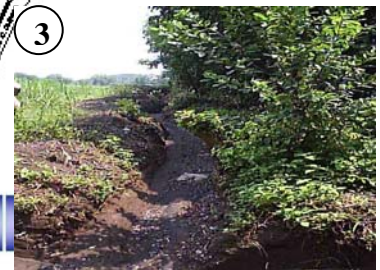
Canaleta que desagua en el Tragante.
