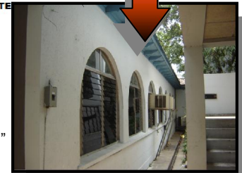
VISTA DE ESCALERAS DAÑADAS EN EDIFICIO "H"
