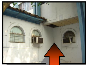
VISTA POSTERIOR DETALLES DE VENTANAS EDIFICIO "H"
