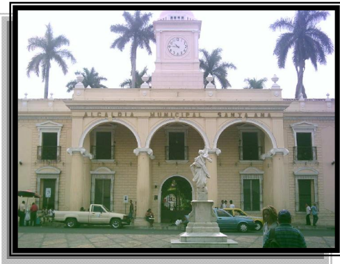
Fotografía No.18 Palacio Municipal de Santaneco, edificación con estilo Clasicista, ubicada en la manzana No. 63 del centro histórico de la ciudad de Santa Ana.
