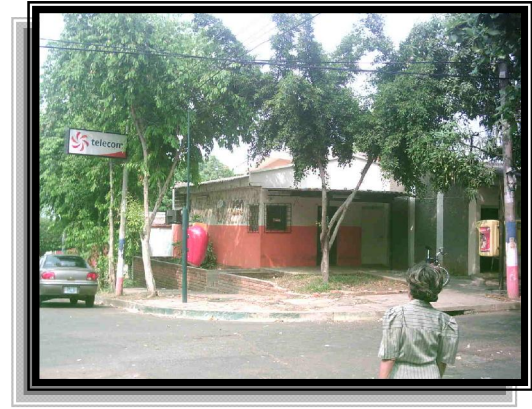
Fotografía No.64 Oficinas de Telecom. sobre la 14a. Avenida Sur.
