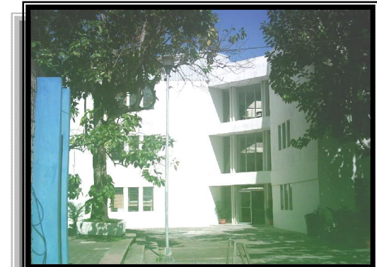
Fotografía No.6 Fachada Principal del centro de desarrollo, zona central.
