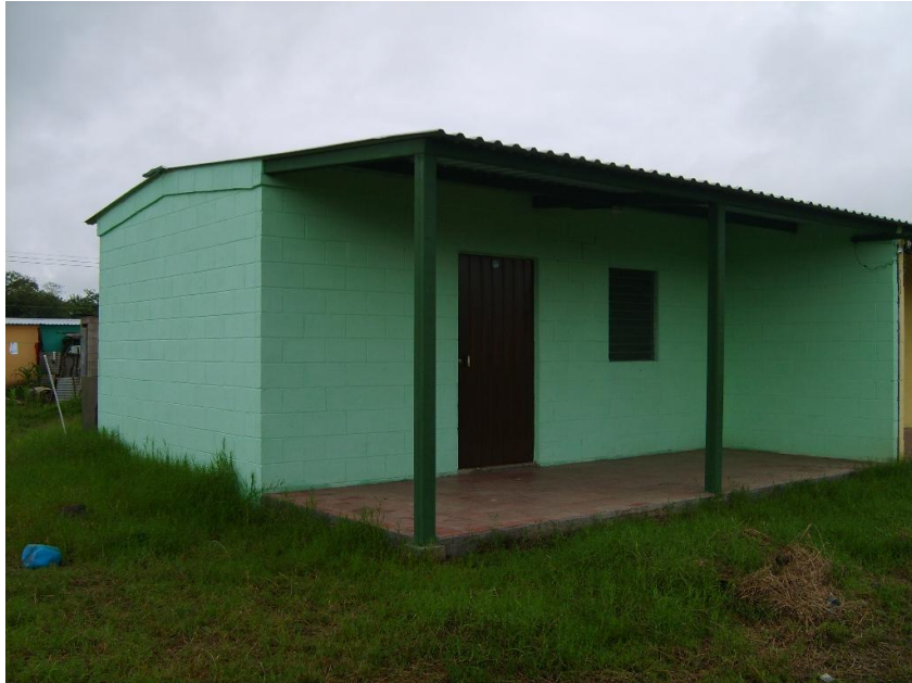
Anexo No.15 Vivienda construida con bloque hueco estándar, hecho de concreto lávico o escoria volcánica molida.
