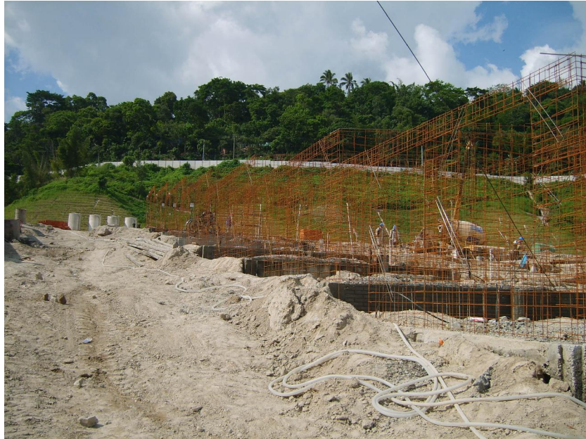
Anexo No.17 Armadura de las paredes en el sistema de paredes de concreto moldeado y vaciado in situ.
