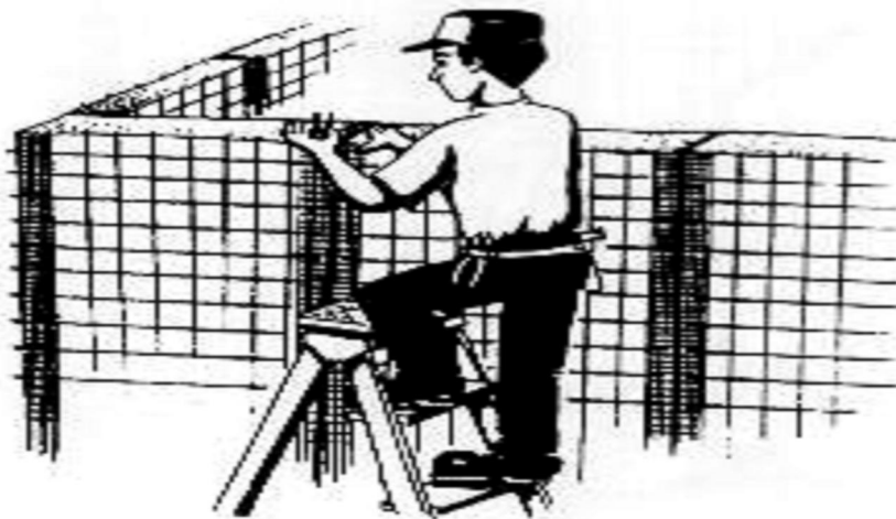
Anexo No.22. Colocación de malla unión entre los paneles.
