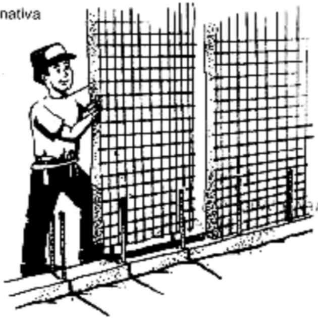
Anexo No.21. Montaje de paneles entre las varillas de refuerzo de 3/8" de diámetro.
