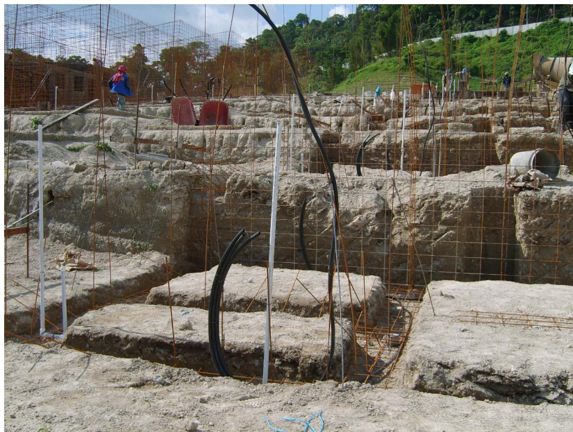
Anexo No. 18 Ductileria hidráulica en el sistema de paredes de concreto moldeado y vaciado in situ.
