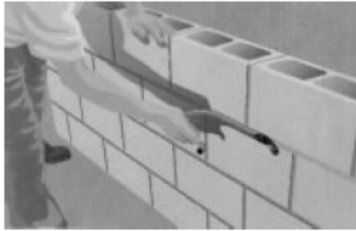
Anexo No.31 Quitando el exceso de mortero.
