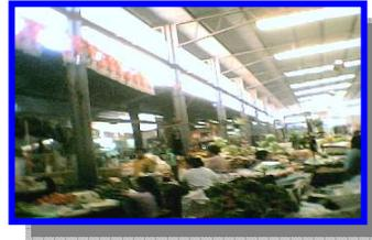
En esta imagen podemos observar la conformación de la edificación; las columnas de hierro y base, el techo de Lámina por vigas macomber y piso de cemento y área estructural afecta, los cuales no conforman un verdadero Mercado municipal.
