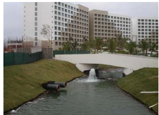
Ejemplo de canales de aguas lluvias.
