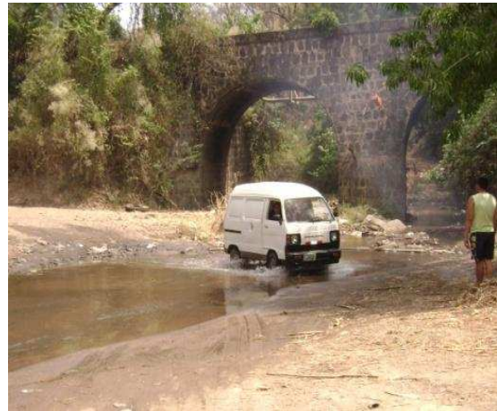
Foto 23: Paso de Vehículos sobre Río Chacalapa.
