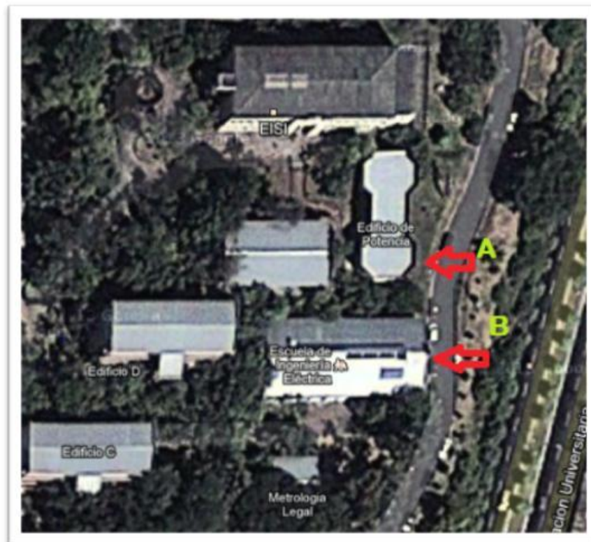
Figura 76. Área de la Instalación de la Estación
