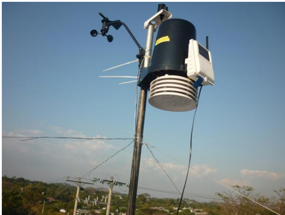
Figura 80. Instalación de Sensores
