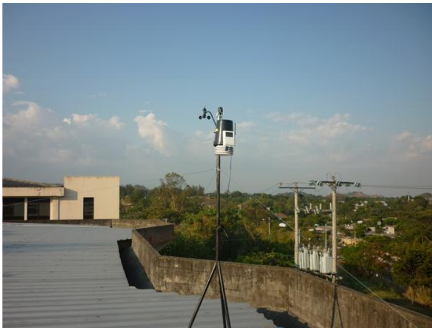
Figura 78. Instalación de la Estación Edificio de Potencia
