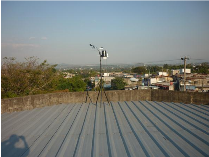
Figura 77. Instalación de la Estación
