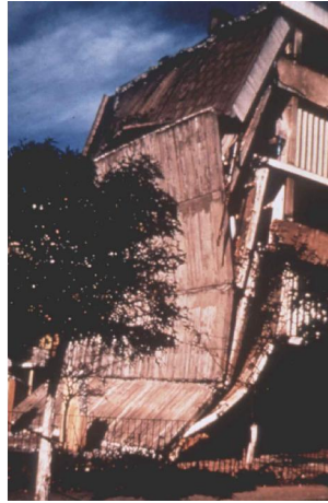
Fig. 1.7. Colapso por discontinuidad en elementos verticales. A la izquierda se presenta el edificio antes del sismo y a la derecha después del sismo.
