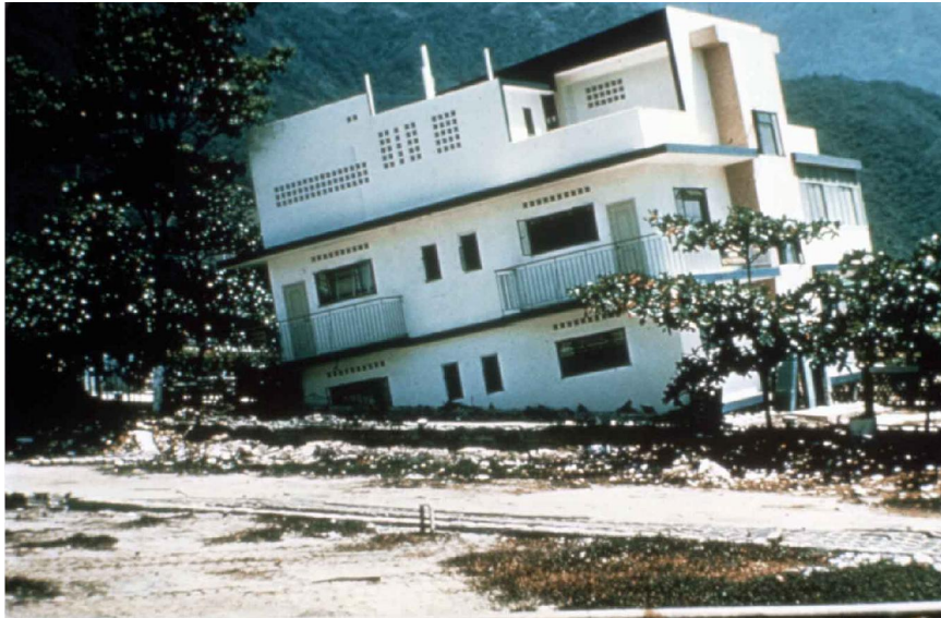
Fig. 1.9 Asentamientos diferenciales en el suelo, provocados por un sismo.
