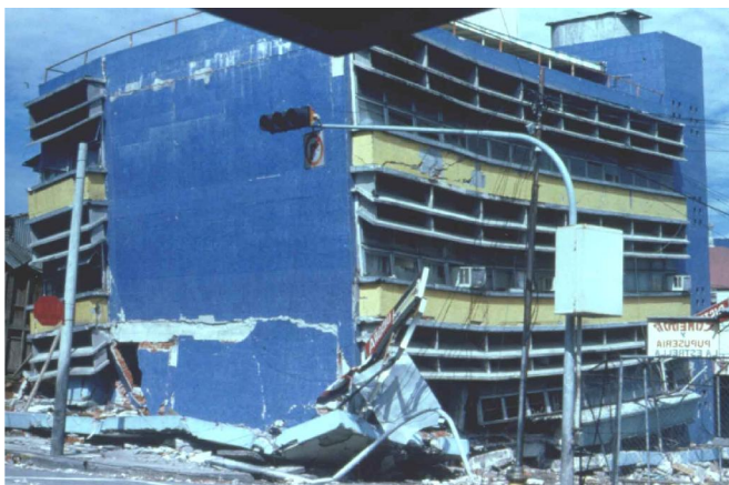
Fig. 1.2. Daño por torsión en una edificación
