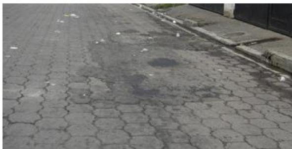
**Fig. 3.28** Baches de asfalto y hundimiento de algunas piezas de adoquín.
