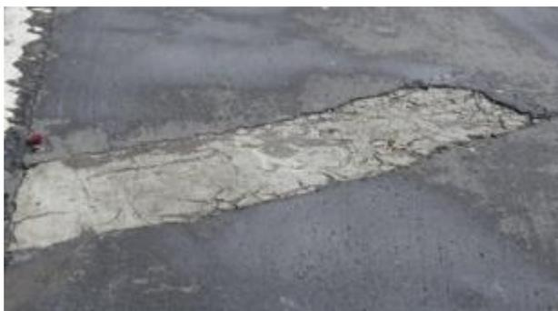
**Fig. 3.50** Bache de concreto por introducción de tuberías
