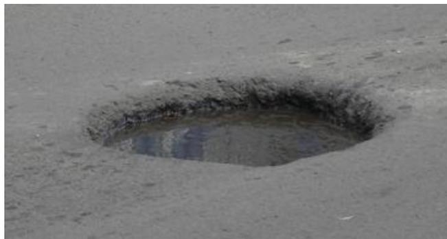
**Fig. 3.39** Perdida del nivel de diseño
