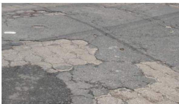
**Fig. 3.29** Baches irregulares de asfalto sobre el adoquinado.
