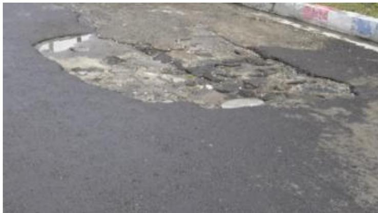
**Fig. 3.19** Empedrado fraguado con carpeta de Asfalto
