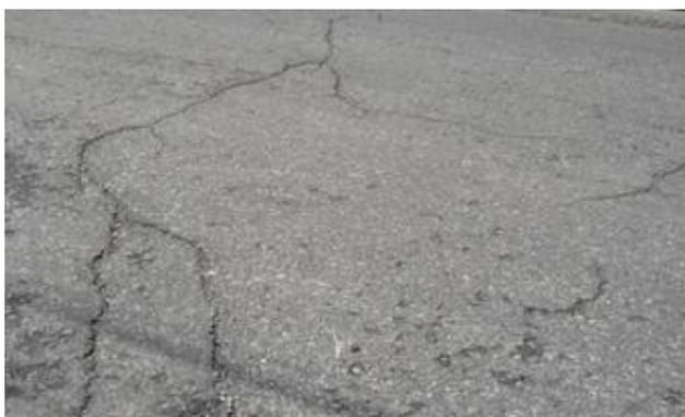
**Fig. 3.54 Peladura, grietas transversales y longitudinales**
