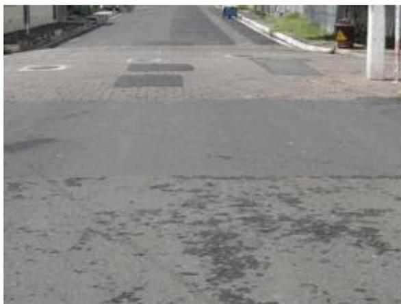
**Fig. 3.51 Peladuras, grietas y baches de asfalto sobre el adoquín**
