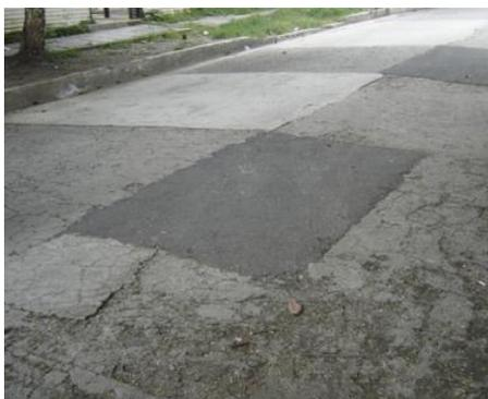
**Fig. 3.25** Tramo empedrado fraguado con baches de asfalto.
