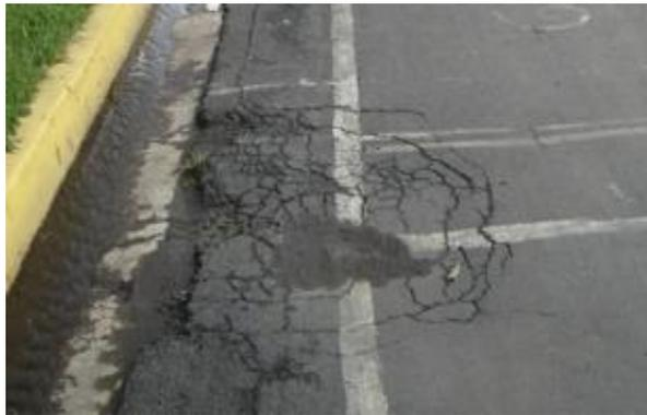
**Fig. 3.38** Daño estructural debido al bombeo de finos
