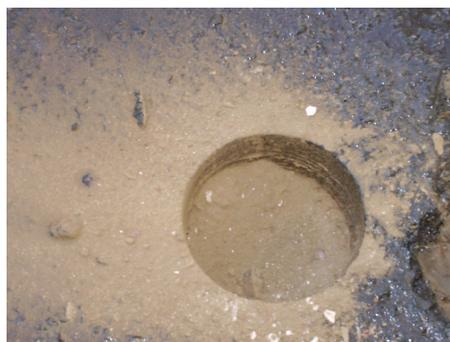
**Fig. 3.56 Hueco después de extraer el núcleo**
