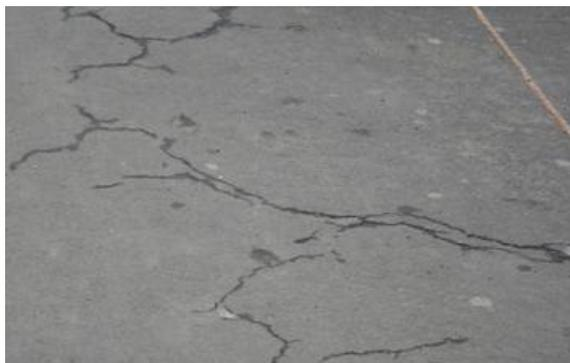
**Fig. 3.43** Grietas transversales y longitudinales
