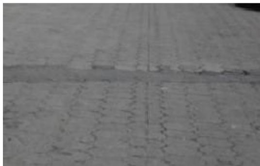
**Fig. 3.27** Baches por la introducción de tuberías y hundimiento de adoquín.
