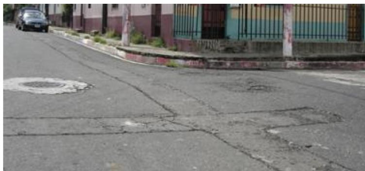
**Fig. 3.34** Parchado de concreto, grietas y baches
