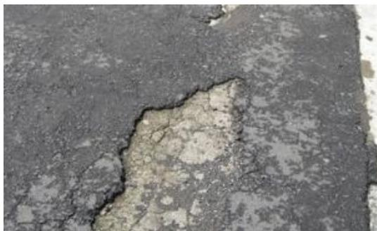
**Fig. 3.48** Perdida de carpeta asfáltica
