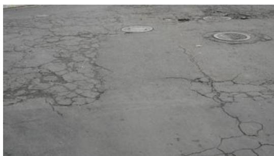
**Fig. 3.40 Piel de cocodrilo, abultamientos, grietas longitudinales y transversales.**
