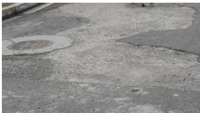
**Fig. 3.33** Huecos y desintegración de bordes
