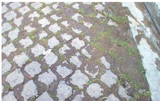
**Fig. 3.16 Hundimiento de adoquines y presencia de vegetación.**
