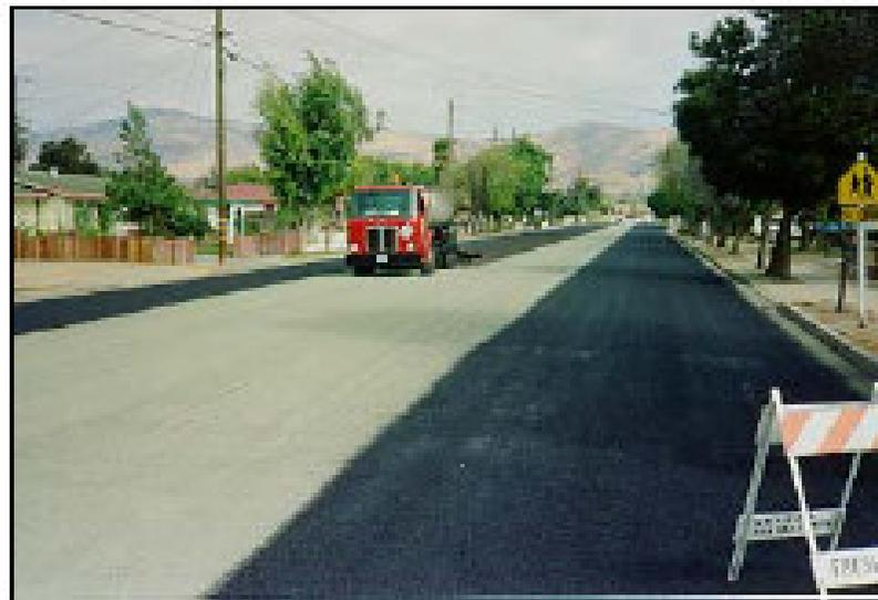
**Figura 2.7** Equipo para Lechada Asfáltica
