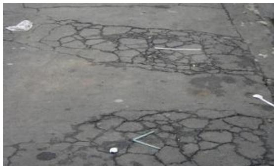
**Fig. 3.41 Piel de cocodrilo con severidad muy alta**
