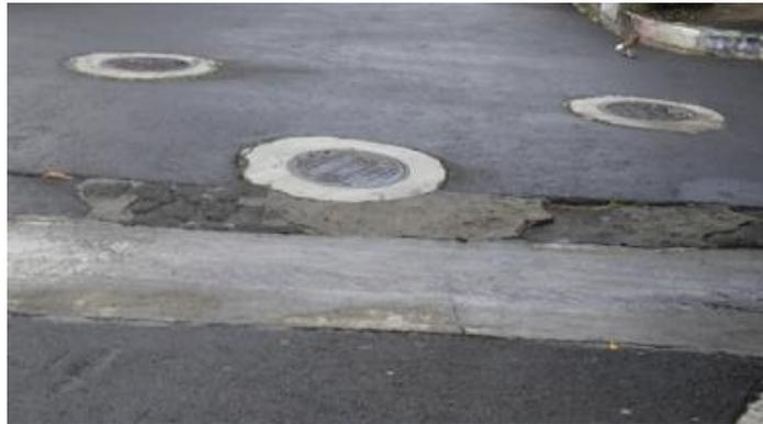
**Fig. 3.18** Falta de junta de dilatación en pozos
