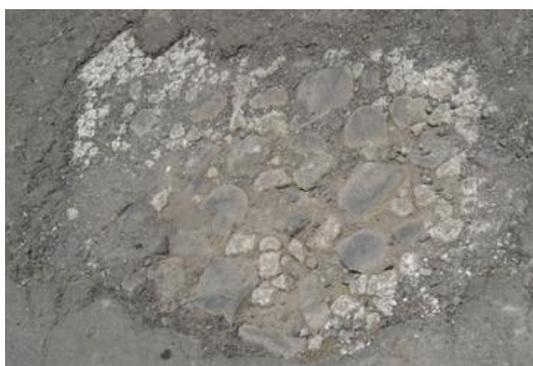
**Fig. 3.20 Huecos y desintegración de bordes.**
