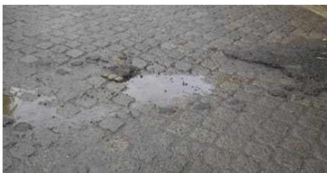
**Fig. 3.44** Hundimiento de piezas de adoquín.
