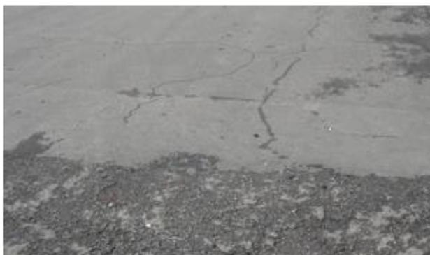
**Fig. 3.47 Peladura, grietas trasversales y longitudinales.**
