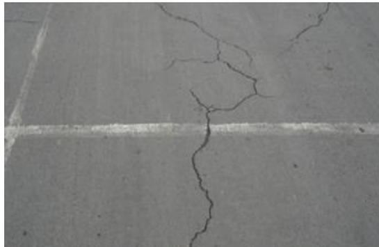
**Fig. 3.35 Grietas longitudinales**
