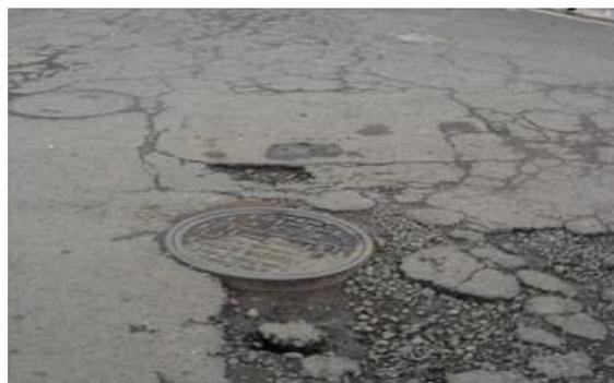
**Fig. 3.42 Grietas transversales y longitudinales, exposición de agregados y baches**
