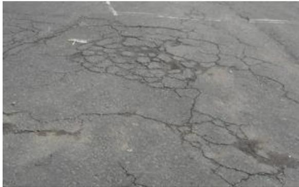
**Fig. 3.37** Piel de cocodrilo con severidad muy alta y peladuras
