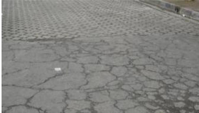
**Fig. 3.17** Grietas por reflexión de juntas en adoquines
