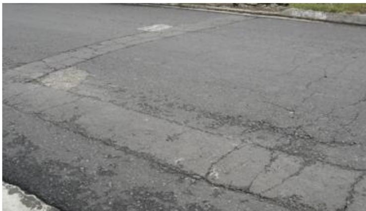
**Fig. 3.30** Grietas transversales y baches de asfalto por introducción de tuberías
