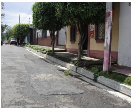
**Fig. 3.26** Pérdida de agregados a lo largo del tramo y bache de asfalto.
