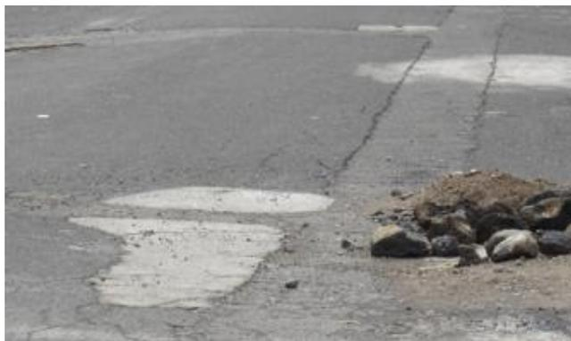
**Fig. 3.32** Parchado de concreto y asfalto, grietas y peladuras
