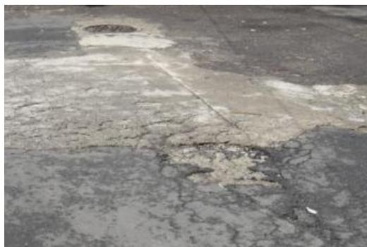
**Fig. 3.49** Baches de concreto grietas y peladuras
