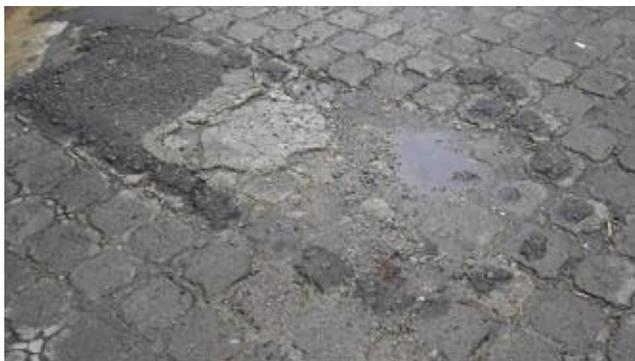
**Fig. 3.45 Hundimiento de piezas de adoquín con bache de asfalto**
