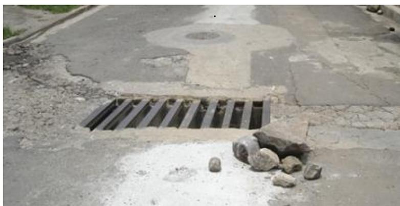
**Fig. 3.23** Huecos, desintegración de bordes, baches y grietas.
