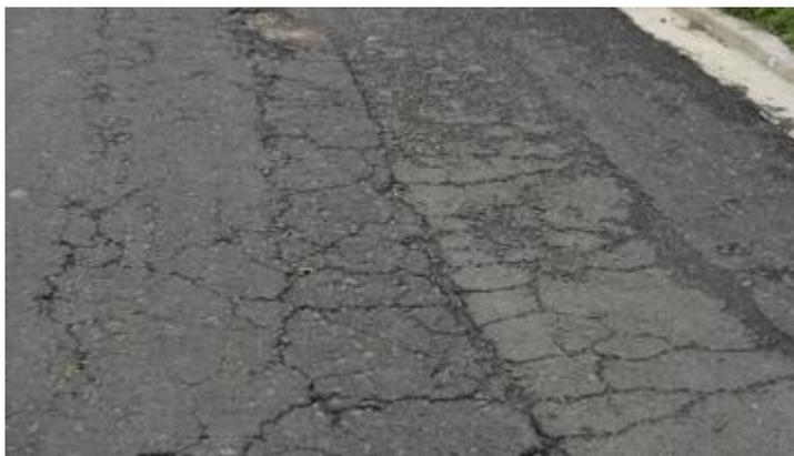
**Fig. 3.31** Piel de cocodrilo y parchado de asfalto.
