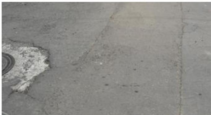
**Fig. 3.22** Baches de asfalto, desintegración de bordes alrededor de pozo y grietas.
