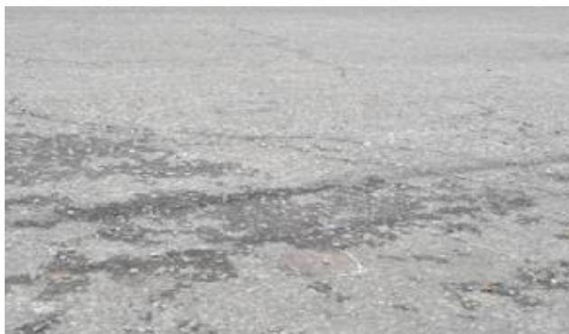
**Fig. 3.52 Peladura con severidad alta**
