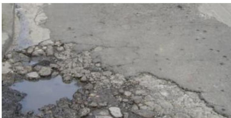
**Fig. 3.21 Huecos, desintegración de bordes por acumulación de agua y grietas**
