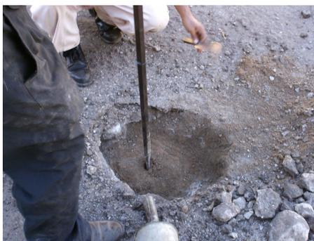
**Fig. 3.57 Exploración del material y espesores de base y sub-base.**
