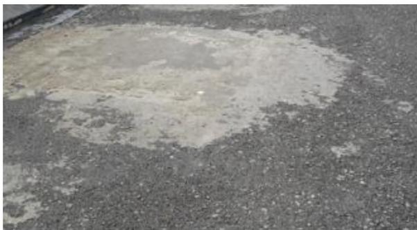
**Fig. 3.53 Parchado de concreto y peladura con severidad alta**
