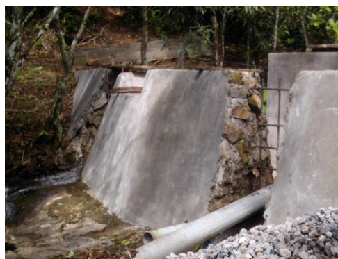
b) lado externo de bocatoma.
