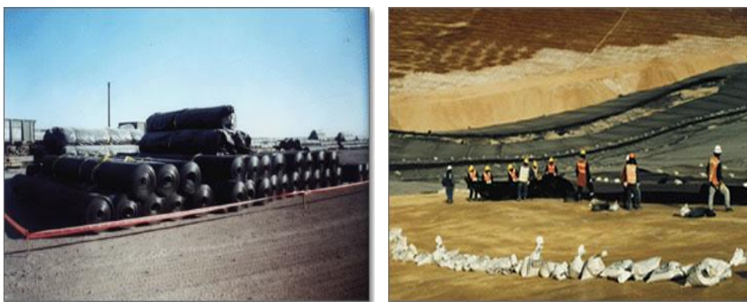
Fig. 3.6.2.1. Rollos de Geomembrana e instalación de Geomembrana.
