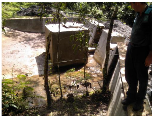
a) lado interno de bocatoma.
