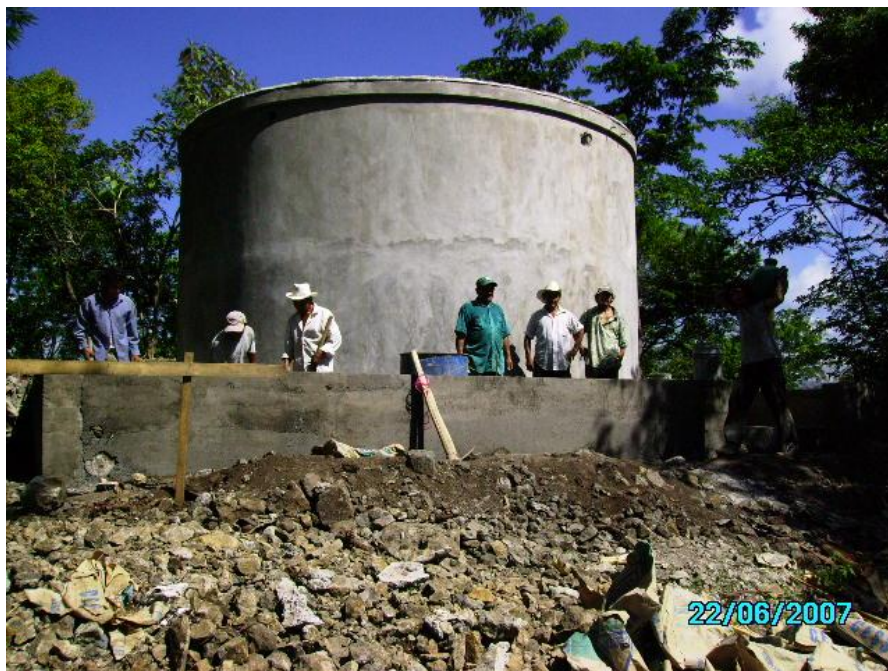
Figura 3.3.2.6.1. Fotografía del tanque de 100m 3 construido en el caserío Cutuco.
