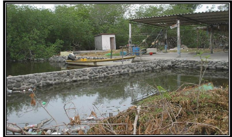
**Foto N. 31** Muro de retención utilizado para aumentar área de construcción en el estero, utilizado como barrera de protección ya que son suelos inestables por la humedad.
