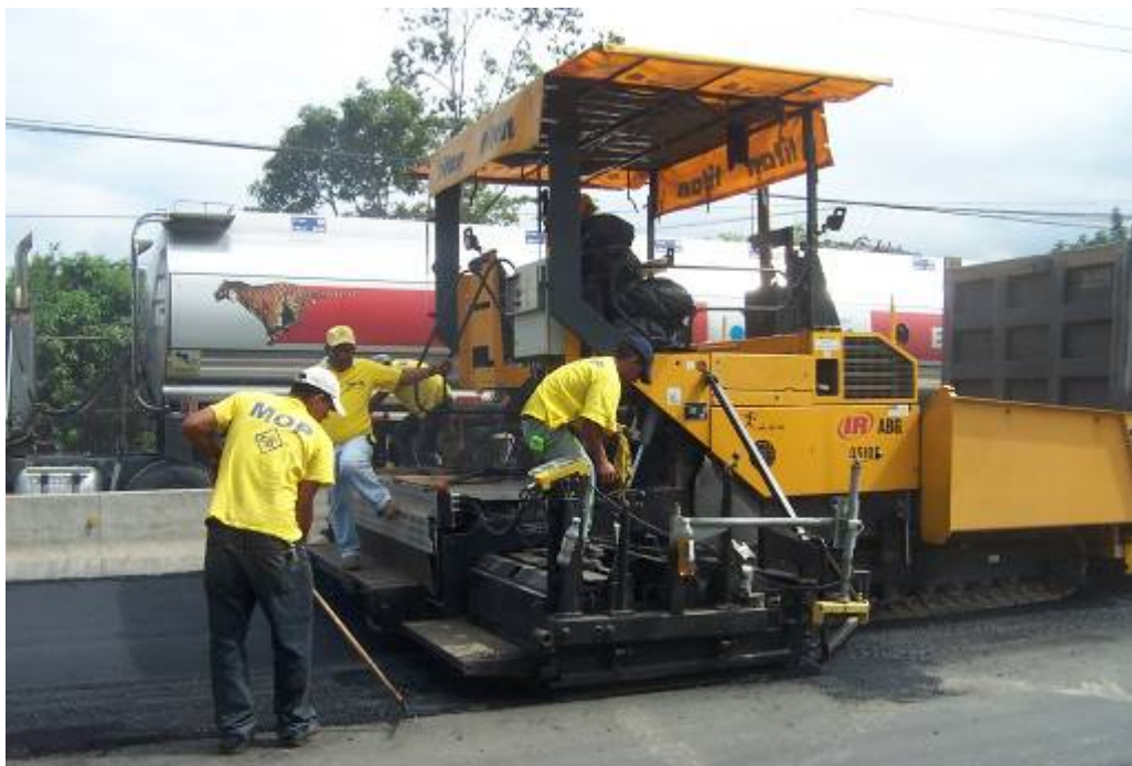
Fotografía 9: Pavimentadora utilizada, para la colocación de la carpeta asfáltica.
