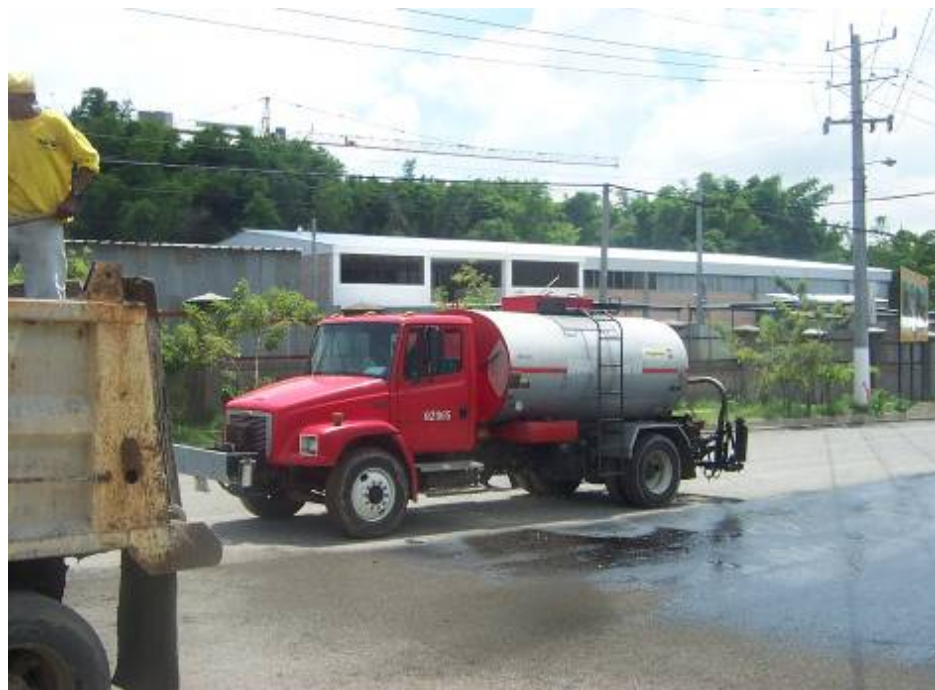
Fotografía 6: Distribuidor de materiales asfálticos.
