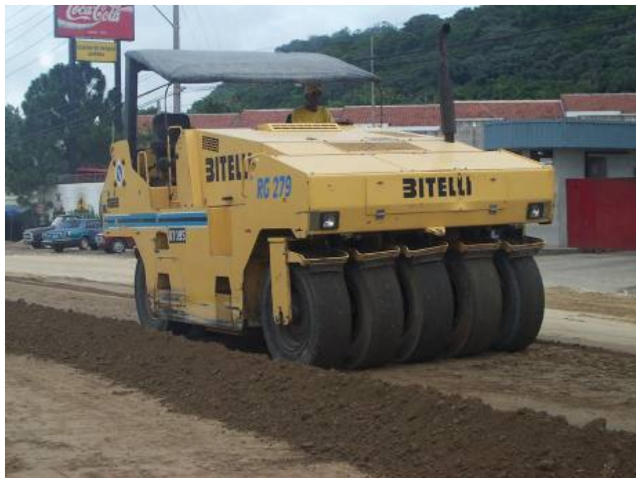
Fotografía 4: Compactadora de rodillo neumático
