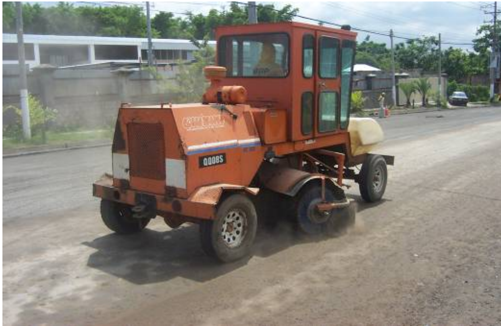
Fotografía 1: Barredora mecánica de cepillo rotatorio, utilizada para la colocación de un riego de imprimación de una superficie de pavimento.
