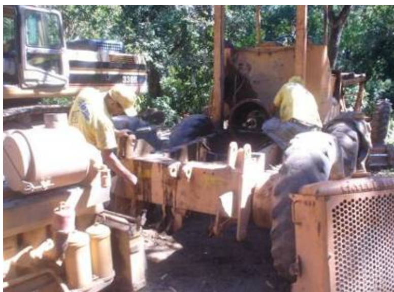
Fotografía 10: Reparación de la transmisión de una motoniveladora.
