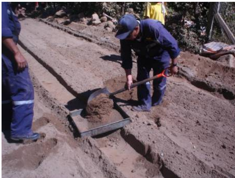
Fotografía 13: Muestreo de agregados para base estabilizada
