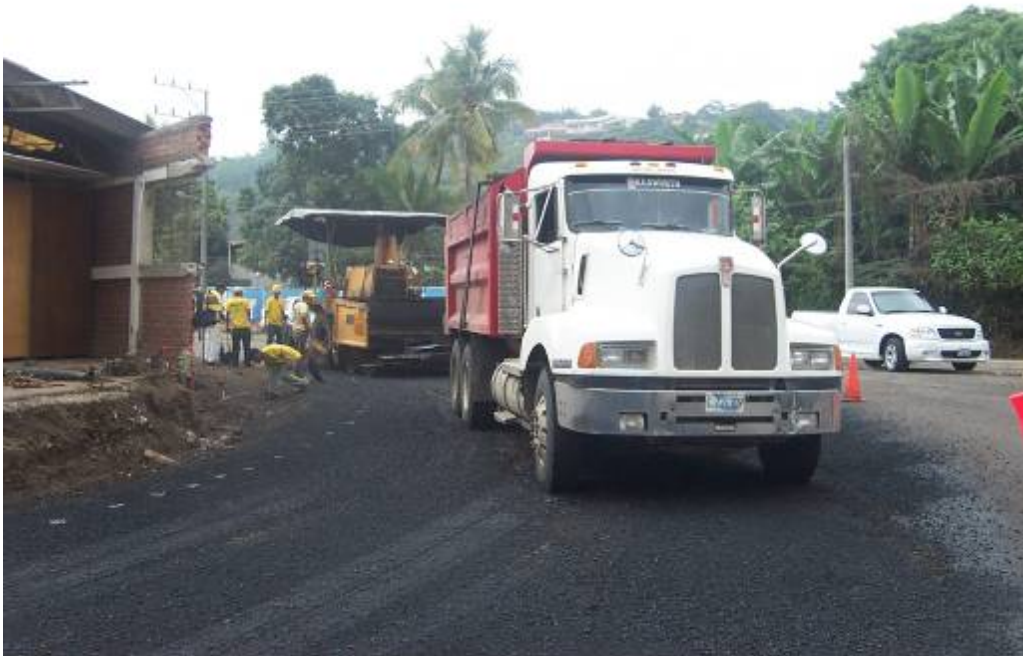
Fotografía 2: Camión de volteo para transporte de mezcla asfáltica.
