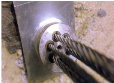
Figura 2.11. Anclajes de cables.
