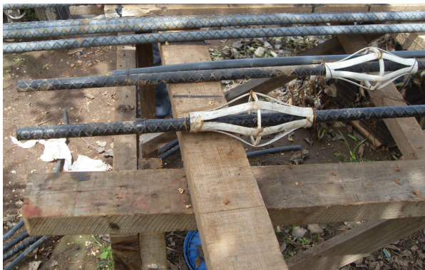
Figura 4.41 Centralizadores manufacturados artesanalmente.
