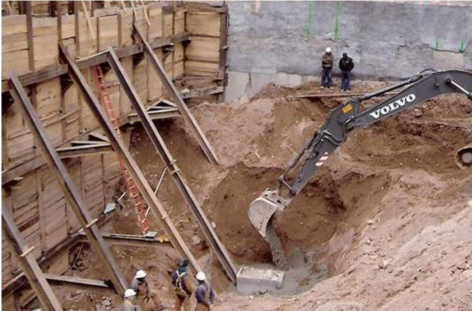
Figura 5.35. Construcción de bloque de soporte en un sistema de puntales inclinados.
