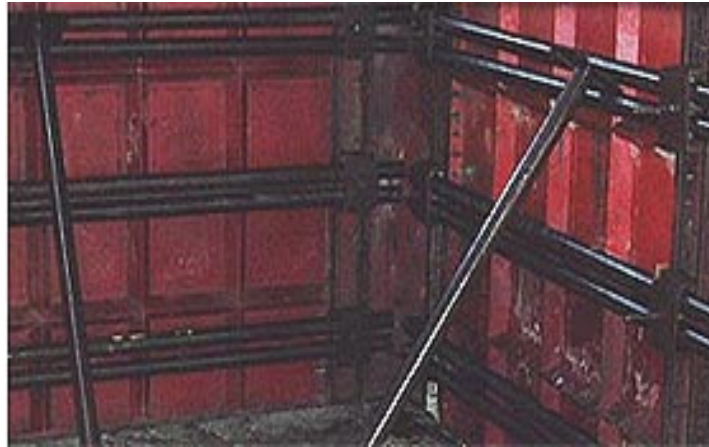
Figura 2.32. Paneles metálicos de revestimiento. Fuente: Nicholson, design and construction, EE UU, 2000.
