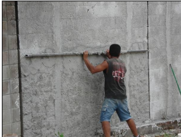
Figura 2.14 Desecho Del Exceso De Mortero.
