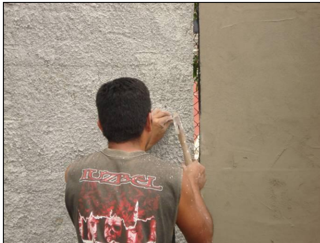
Figura 2.20 Colocación De Cordeles.
