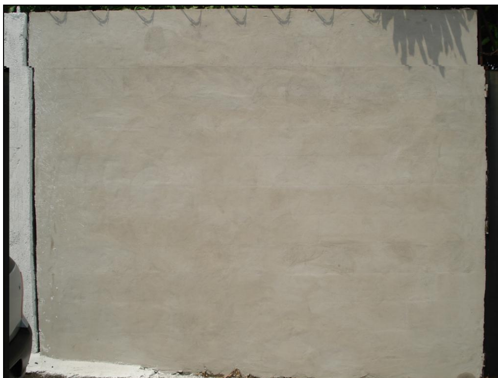
Figura 5.2 Repello con cementante predosificado a los 21 días de haber sido colocado.
