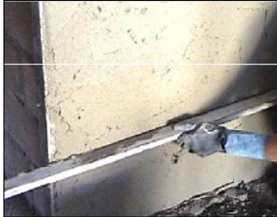
Figura 2.9 Nivelación De Las Paredes.
