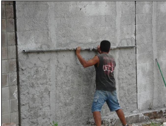
Figura 2.24 Colocación De La Segunda Capa De Repello.
