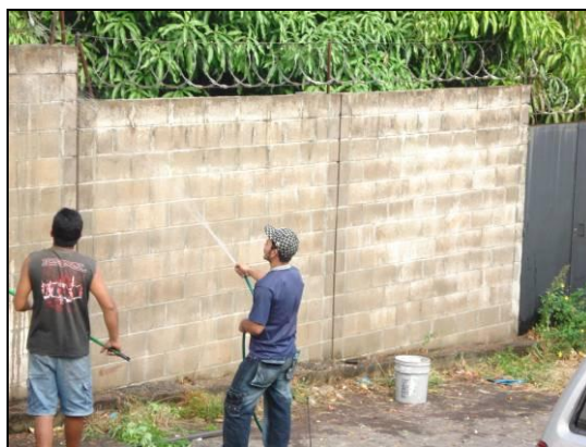
Figura 2.13 Limpieza Previa De La Superficie.
