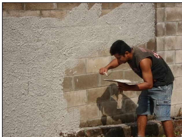
Figura 2.22 Colocación De La Primera Capa De Repello
