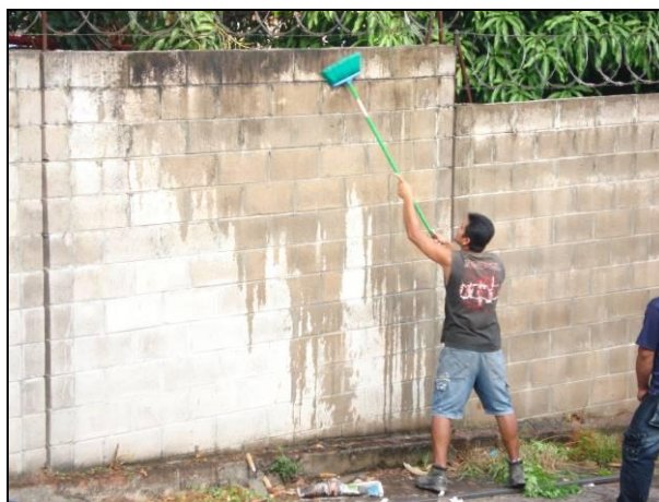
Figura 2.18. Limpieza De Superficie Antes De La Aplicación Del Repello.
