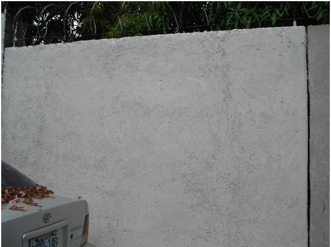
Figura 5.9 Repello con mortero elaborado con cemento Pórtland mezclado con el contenido máximo de cal a los 14 días de haber sido colocado.
