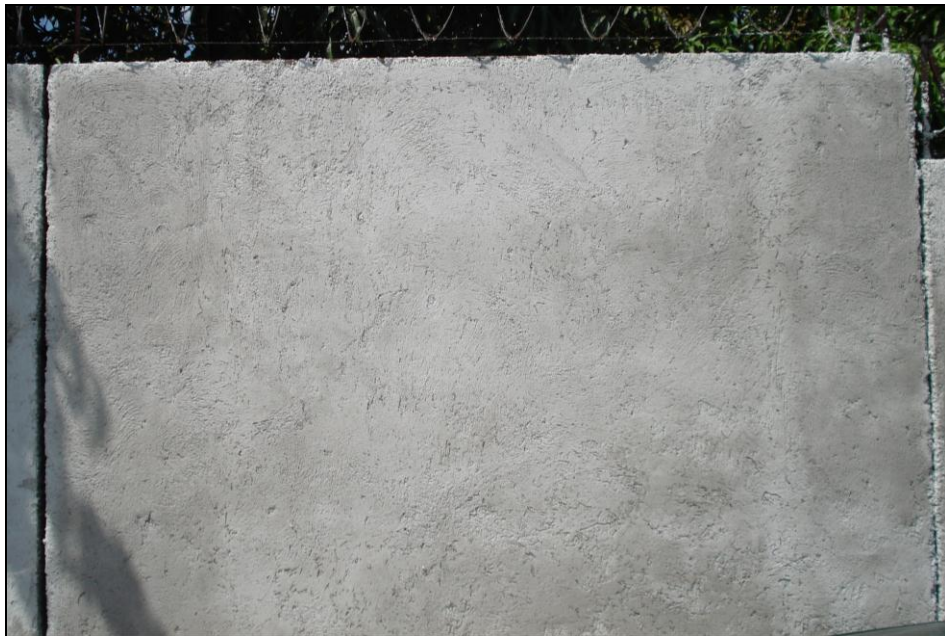
Figura 5.11 Repello con mortero elaborado con cemento Pórtland mezclado con el contenido máximo de cal a los 45 días de haber sido colocado.
