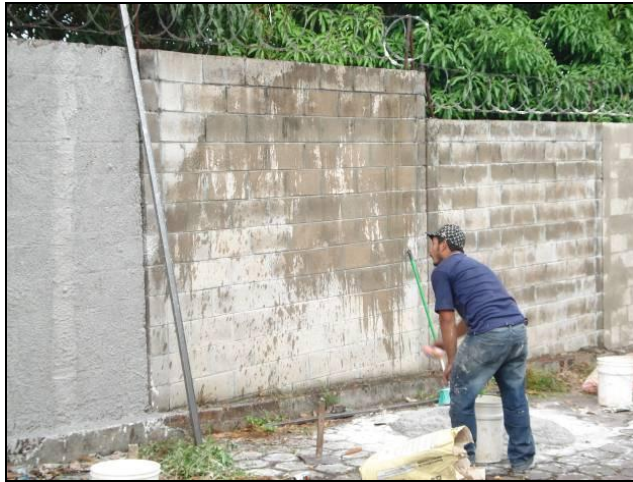
Figura 2.21 Humedecer Paredes Antes De Colocar El Repello
