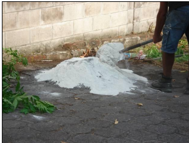
Figura 2.15 Mezclado De Materiales.
