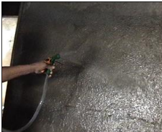
Figura 2.11 Curado de Paredes.
