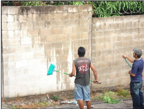
Figura 2.19 Preparación De La Superficie Para Realizar El Repello
