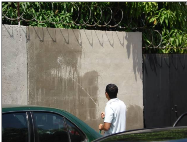
Figura 2.26 curado del repello.
