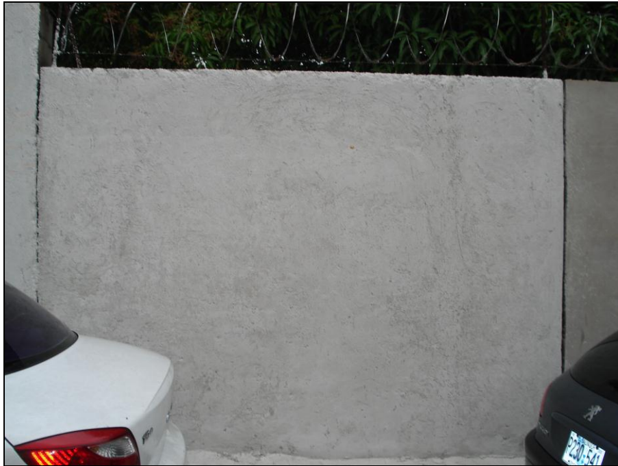
Figura 5.10 Repello con mortero elaborado con cemento Pórtland mezclado con el contenido máximo de cal a los 21 días de haber sido colocado.
