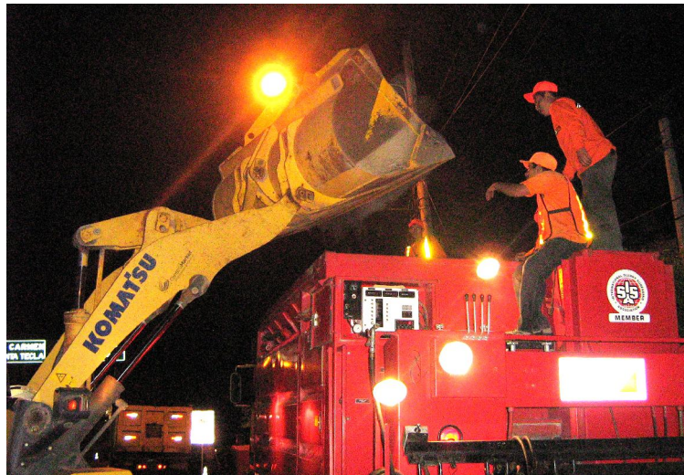
Fotografía 8.9 Cargador Frontal colocando agregado a la tolva de camión de micro
