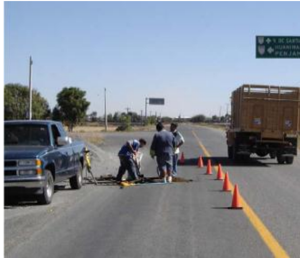
Fig. 2.5. Elaboración de una calicata
