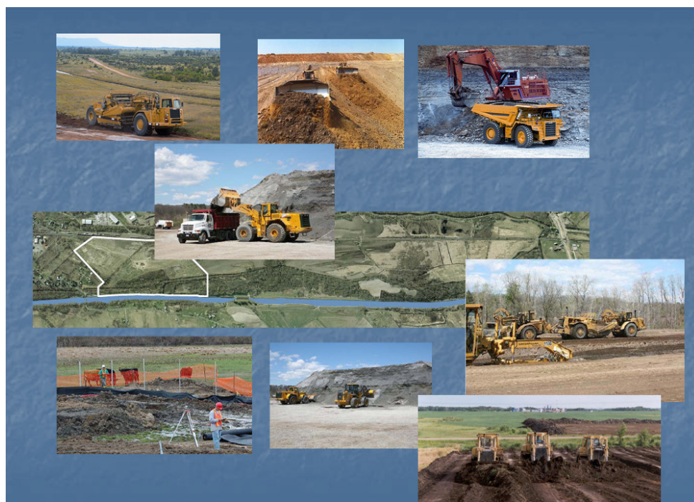
Figura 5.1 Principales actividades del movimiento de tierra, se muestra diferentes equipos trabajando en obras de terracería.
