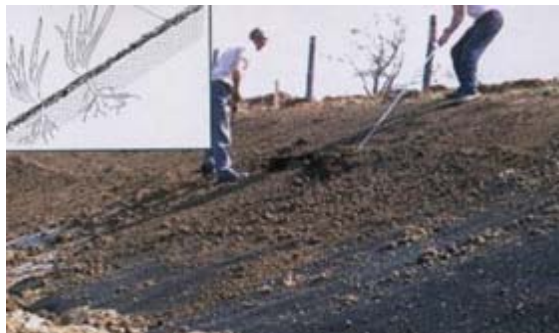
Fotografía 4. 30. Esparcimiento de tierra sobre una geomanta para ayudar al crecimiento de la vegetación que protegerá al talud.
