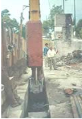
Fotografía 4. 65. Excavación de zanja para la construcción de un muro milán
