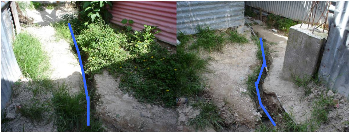
a) b) Fotografía 5.2 a y b: Estado general de los pasajes en la comunidad La Providencia, en los que se muestra los drenajes superficiales provenientes de las viviendas.
