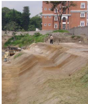
Fotografía 4. 8: Berma conformada en talud, contiguo al Instituto Emiliani, Antigua Cuscatlán.
