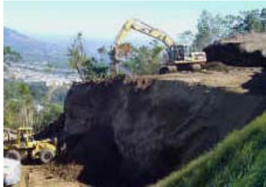
Fotografía 4. 6: Proceso de abatimiento en taludes de Corte, Col. Las Colinas, La Libertad
