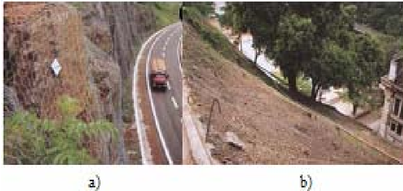
Fotografía 4. 36. Redes de alta resistencia usadas para evitar que las piedras que se desprenden dañen a) las carreteras y b) edificios cercanos.
