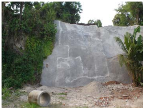
Fotografías 4.43 y 4.44 . Revestimiento de mortero para la estabilización de un talud ubicado en Santo Tomás, sobre la Carretera Panamericana.
