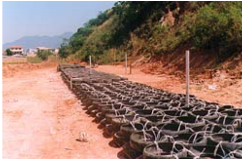
Fotografía 4. 64. Esquema de la colocación y atado de las llantas.
