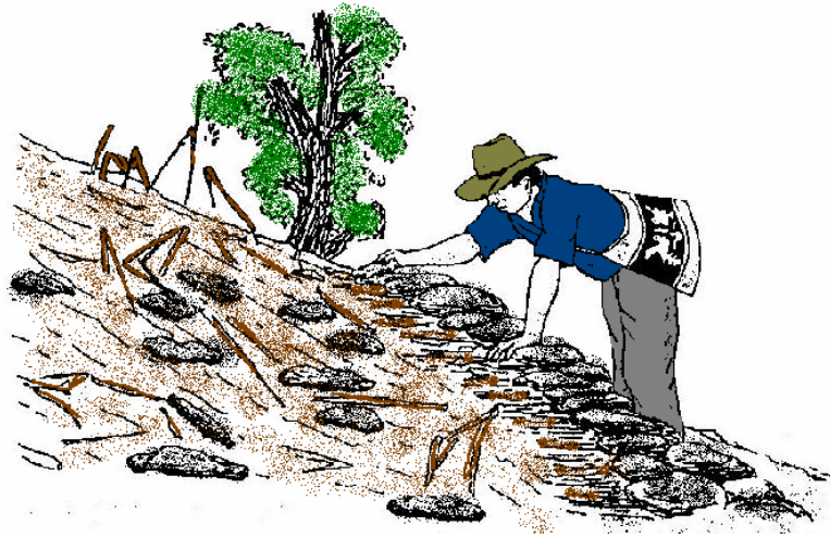
Figura 4. 35. Construcción de una barrera muerta usando rastrojos y piedras
