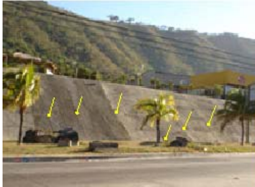
Fotografía 4. 45. Talud de la planta de procesamiento de Café Rico sobre la Autopista a Comalapa protegido con una capa de mortero. Pueden distinguirse las fajas que se hicieron para su construcción, las cuales se señalan en amarillo.
