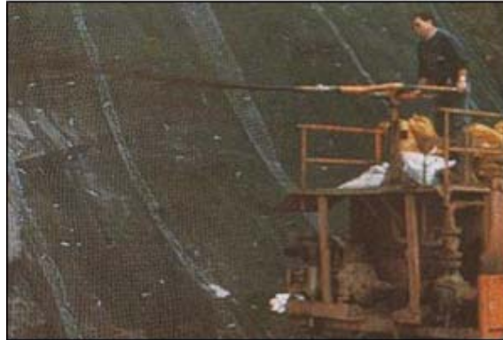
Fotografía 4. 32. Hidrosiembra sobre un talud de gran inclinación.
