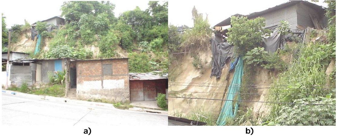
a) Fotografía 5.3. a) Viviendas que se ubican al pie del talud y que reciben todo el material que se desprende desde el talud, corriendo el riesgo de ser soterradas. b) Pérdida de una porción de la vivienda mostrada debido a un deslizamiento ocurrido durante el huracán Stan.
