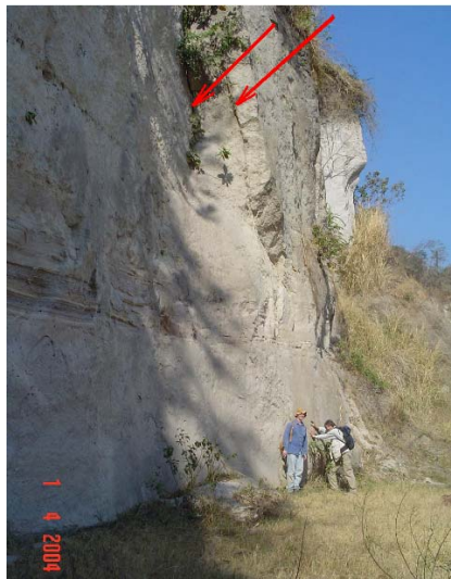
Fotografía 2.1. Se señalan las fisuras generadas por la exfoliación en un talud de tierra blanca
