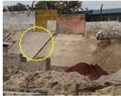
Fotografías 4.47 y 4.48. Recubrimiento de taludes: a) utilizando piedras y b) unidades de mampostería. Los lloraderos o drenajes se hacen sólo si hay problemas de saturación.
