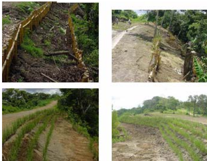
Fotografía 4.53. Sectores aledaños a Las Colinas en Santa Tecla. Se han utilizado barreras vivas para estabilizar taludes en dichas zonas
