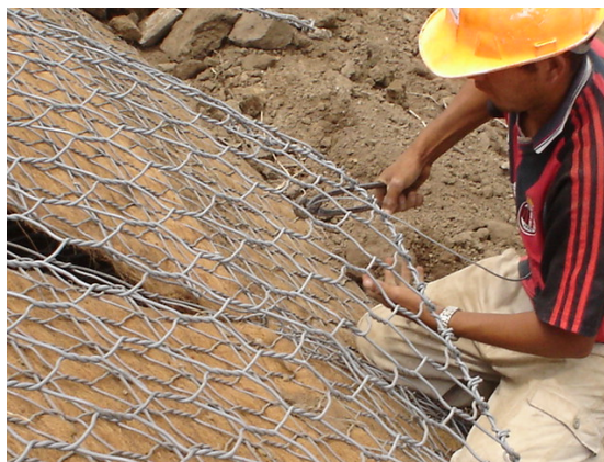
Fotografía 4.80. Amarrado de los elementos del Sistema Terra Mesh, haciendo uso de alambre galvanizado de alta resistencia.
