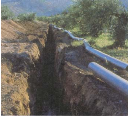
Fotografía 4. 20: Zanja para la colocación de tubería de un drenaje longitudinal. Tomado de libro "Ingeniería Geológica".
