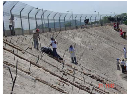
Fotografías 4. 92 y 4.93. Trazo y perforación de puntos de inyección, terraplén de presa hidroeléctrica (Cortesía de Rodio-Swissboring)
