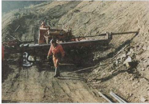
Fotografía 4. 22. Máquina perforadora para la instalación de drenajes horizontales en taludes, tomada de libro "Ingeniería Geológica".
