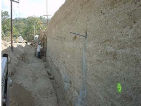
Fotografía 4.67 y 4.68. Ejemplos del trazado de puntos de anclaje (Cortesía de CPK consultores)
