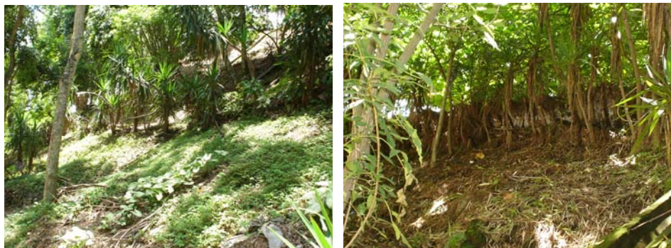
Fotografía 4.54. Utilización de barreras vivas con izote para la estabilización de un talud.
