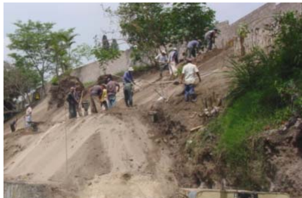
Fotografía 4.9: Medición en campo para la conformación de bermas, talud contiguo al Instituto Emiliani, Antigua Cuscatlán.
