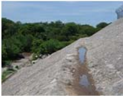
Fotografías 4.47 y 4.48. Recubrimiento de taludes: a) utilizando piedras y b) unidades de mampostería. Los lloraderos o drenajes se hacen sólo si hay problemas de saturación.
