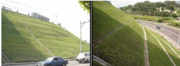
Fotografía 4. 49. Talud sobre el km 11 ½ de la carretera al Puerto de la Libertad, estabilizado utilizando grama y un sistema de drenaje superficial. Su altura es de 25 m con una inclinación de 45^\circ aproximadamente.
