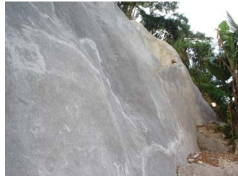
Fotografías 4.43 y 4.44 . Revestimiento de mortero para la estabilización de un talud ubicado en Santo Tomás, sobre la Carretera Panamericana.
