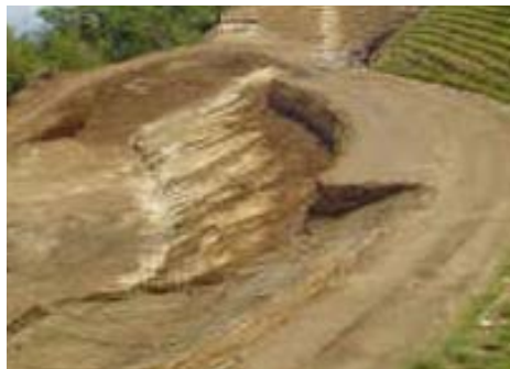
Fotografía 4. 5: Talud en proceso de perfilado, Col. Las Colinas, La Libertad.
