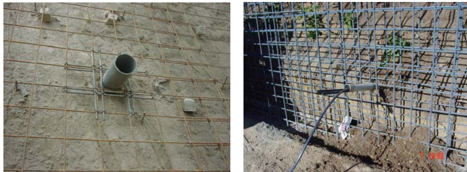
Fotografías 4.70 y 4.71. Instalación de anclajes
