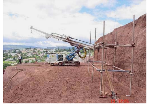
Figura 4. 76 y Fotografía 4. 88. Esquema y Ejemplo de perforación para la introducción de los nails
