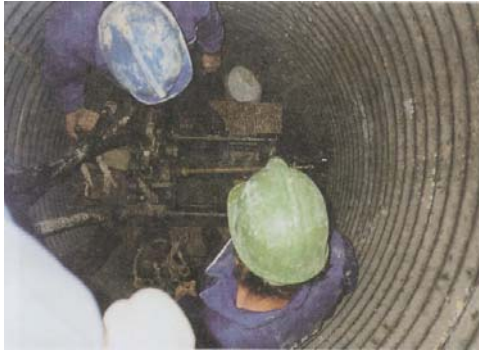
Fotografía 4. 23. Perforación de drenes horizontales desde el interior de un pozo de drenaje para conectar a un pozo contiguo.
