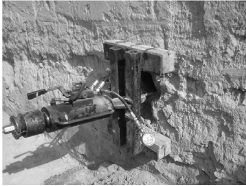
Fotografías 4.73 y 4.74. Tensado de anclaje convencional haciendo uso de un gato hidráulico, Equipo de tensado para un anclaje tipo Manta Ray.
