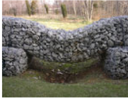
Fotografía 4. 59. Ejemplo de la flexibilidad de las estructuras de gaviones
