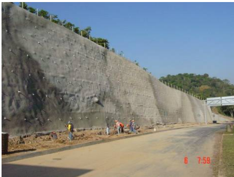
Fotografías 4.85 y 4.86. Taludes estabilizados con la técnica de Soil Nailing, Boulevard Orden de Malta, Santa Elena.
