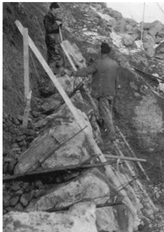
Fotografía 4. 58. Construcción de un muro de piedra.
