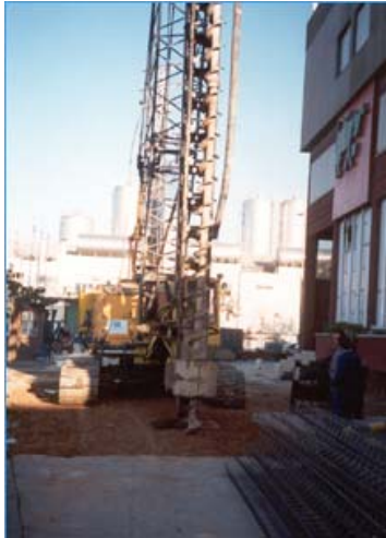
Fotografía 4. 76. Perforación para la instalación de un pilote.
