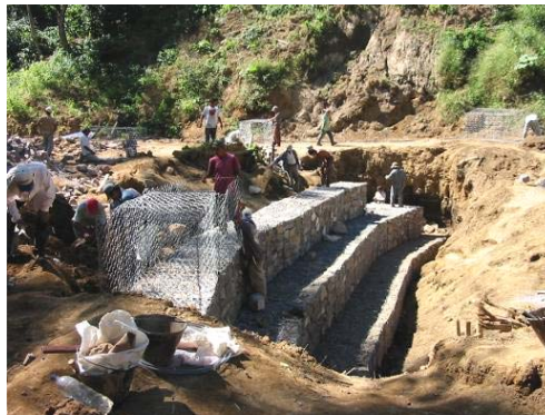
Fotografía 4. 61. Colocación de las hileras de gaviones.
