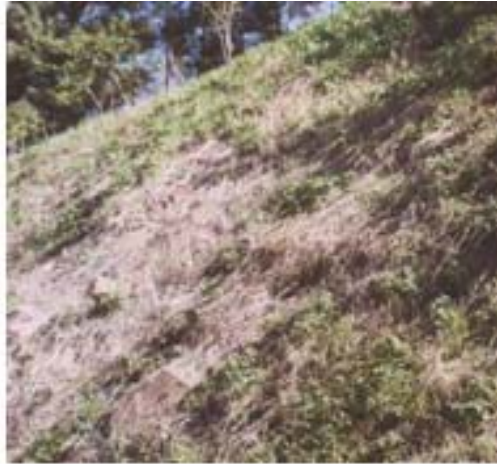
Fotografía 4. 39. Talud con la apariencia de una ladera natural; sin embargo, es un talud estabilizado usando una red de alta resistencia.
