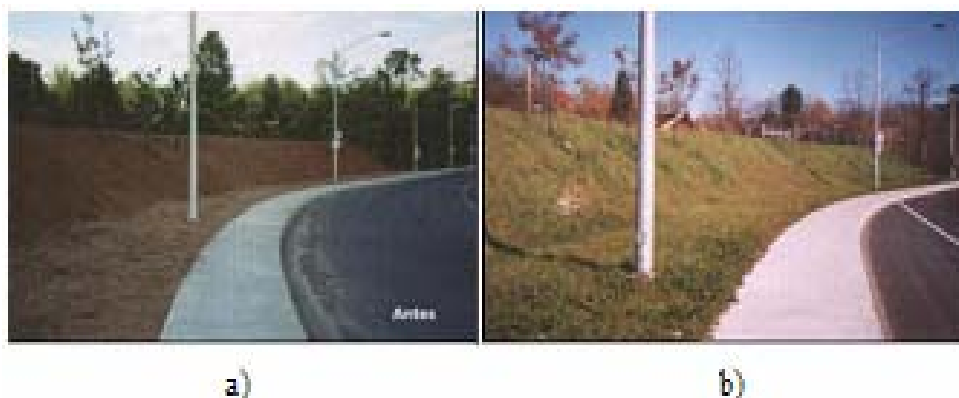
Fotografía 4. 24. Estabilización de un talud con geosintéticos: a) superficie del talud antes de usar geosintéticos y b) se observa el crecimiento de vegetación beneficiado por el material geosintético utilizado.
