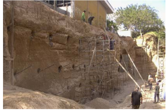
Fotografía 4.67 y 4.68. Ejemplos del trazado de puntos de anclaje (Cortesía de CPK consultores)
