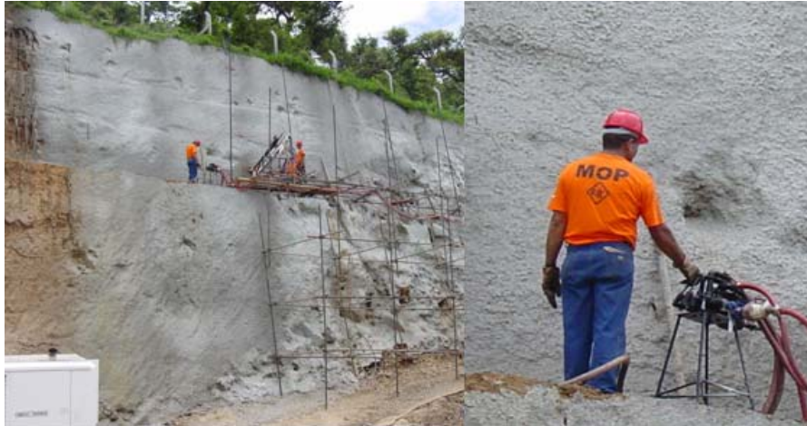
Fotografía 4. 41. Este talud ha sido revestido con concreto lanzado para evitar que la superficie del mismo quede a la intemperie y afecte los trabajos futuros. A pesar de las irregularidades en ciertas partes del talud, debidas al material que lo constituye, el concreto lanzado las ha cubierto.
