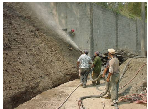
Figura 4. 77 y Fotografía 4. 89. Esquema y Ejemplo del concreto lanzado aplicado sobre malla estructural
