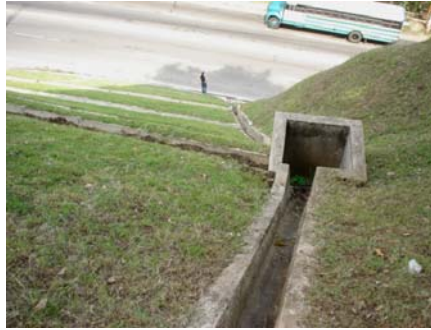
Fotografía 4. 19: Caja de concreto terminada en talud, Km. 12 Carr. a La Libertad.
