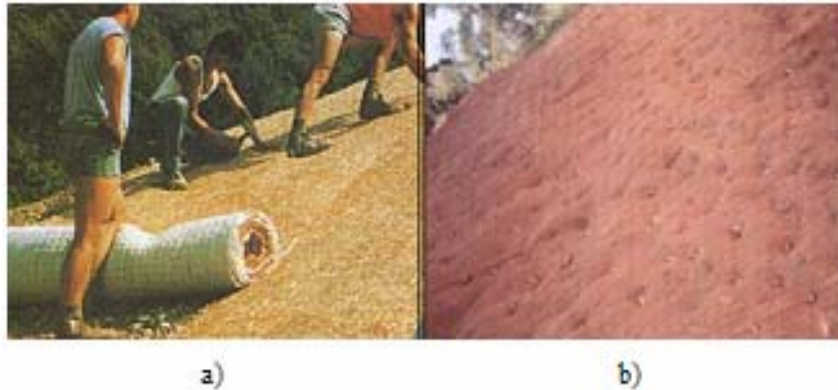
Fotografía 4. 28 Instalación de biomantas: a) Proceso de instalación de una biomanta y b) vista de un talud después de colocada una biomanta
