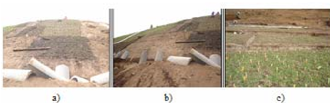
Fotografía 4. 50. Proceso de siembra de grama sobre un talud de la Residencial Miramar en San José Villanueva, utilizando fragmentos de plantas. a) y b) siembra de fragmentos de plantas y colocación de drenajes superficiales. c) estacas de madera para ayudar a soportar los fragmentos mientras las raíces penetran en el suelo del talud.
