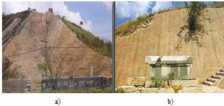
Fotografía 4. 29 Utilización de biomanta reforzada con malla de doble torsión debido a la gran inclinación de los taludes. a) Talud de una carretera b) Talud en un lugar de gran afluencia de personas.
