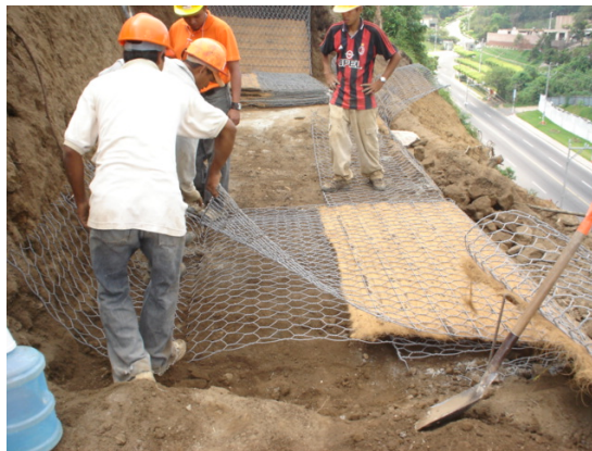
Fotografía 4.84. Colocación de los elementos del Sistema Terra Mesh para la conformación de las capas siguientes.
