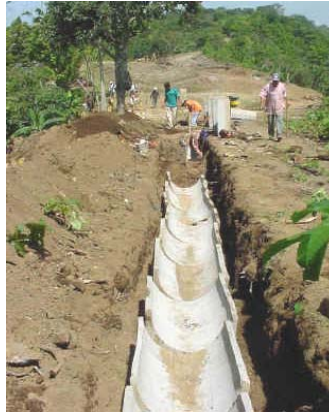
Fotografía 4. 15: Colocación de cuneta circular prefabricada, Col. Las Colinas, La Libertad.
