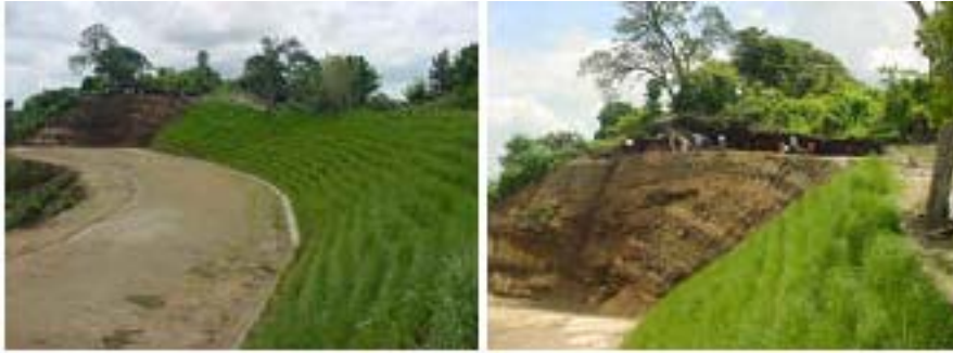
Fotografía 4.55. Sector Las Colinas en Santa Tecla. Se observa el crecimiento de zacate vetiver y los trabajos de conformación de terraza para su siembra.
