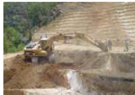
Fotografías 4. 2 y 4.3: Cargador y retroexcavadora realizando trabajos para la conformación del talud, Col. Las Colinas, La Libertad.
