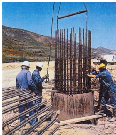
Fotografía 4. 77. Colocación de la armadura de un pilote.
