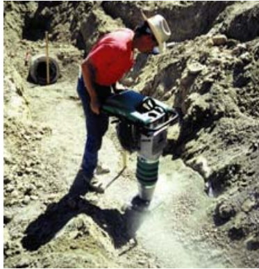
Fotografía 4. 14. Compactación del material base de la cuneta.
