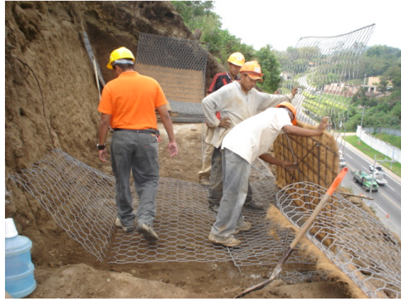
Fotografía 4.83. Colocación y desdoblado de los elementos del sistema Terra Mesh.
