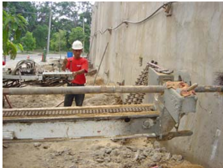
Fotografía 4.69 y Figura 4.63. Esquema del proceso de perforación para alojar el ancla.
