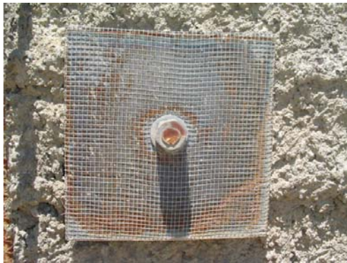
Fotografía 4. 72. Cabezal del ancla con el refuerzo de la placa de apoyo colocado para su posterior colado.
