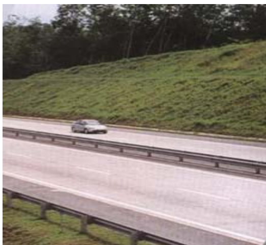
Fotografía 4. 25. Talud estabilizado utilizando geosintéticos
