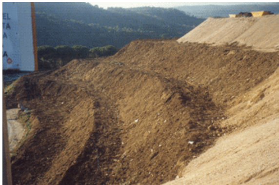
Fotografía 4.51. Recubrimiento de un talud (Llinars del Vallès, España), utilizando la técnica del Mulching.
