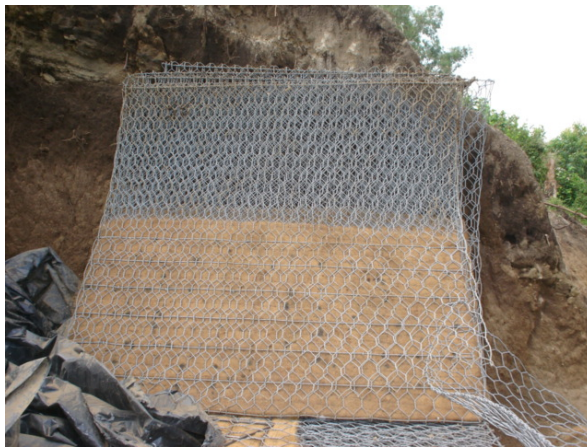
Fotografía 4.78. Elementos utilizados para la conformación de taludes con el sistema Terra Mesh
