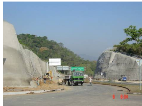
Fotografías 4.85 y 4.86. Taludes estabilizados con la técnica de Soil Nailing, Boulevard Orden de Malta, Santa Elena.
