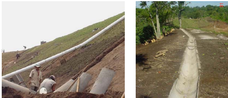
Fotografías 4.11 y 4.12: Construcción de cunetas en bermas y en la corona de un talud, utilizando elementos prefabricados de concreto.
