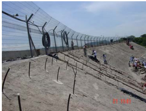
Fotografías 4. 92 y 4.93. Trazo y perforación de puntos de inyección, terraplén de presa hidroeléctrica (Cortesía de Rodio-Swissboring)
