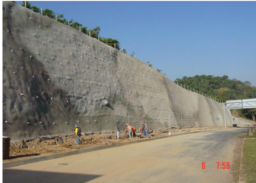
Fotografía 3. 12 Estabilización de talud en Boulevard Orden de Malta
