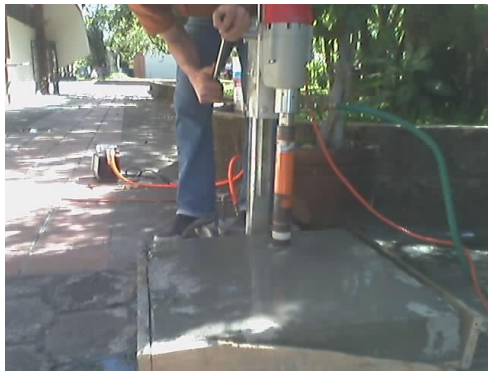
Fotografía 4.17 Extracción de Núcleos a paneles de Concreto Lanzado.
