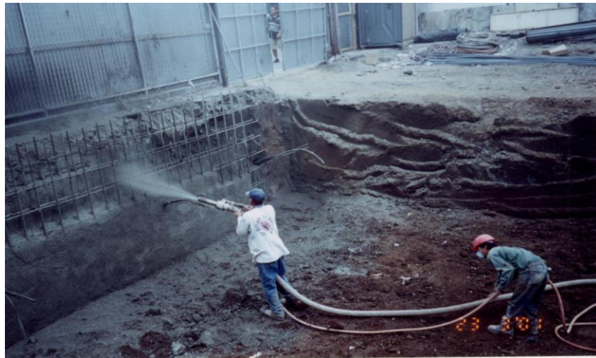
Fotografía 3. 1 Boquilla perpendicular a la superficie
