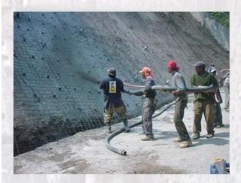
Fotografía 3. 16 Lanzado de concreto en talud
