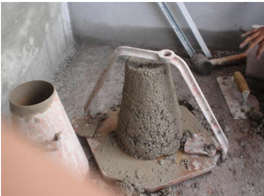
Fotografía 4.11 Prueba de revenimiento realizado en el diseño de concreto con cemento C - 1157.
