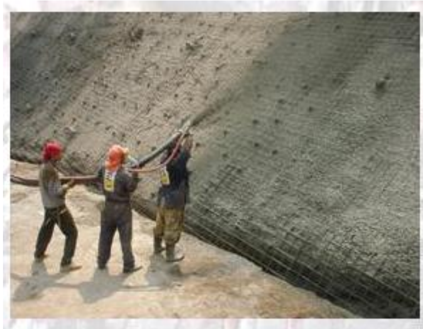
Fotografía 3. 14 Lanzado de concreto en talud
