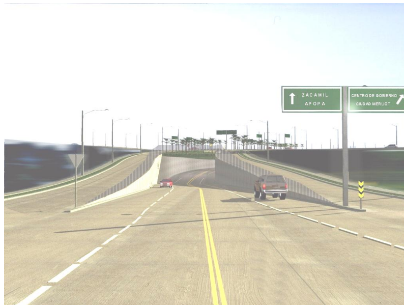
Fotografía 3. 15 Paso a desnivel constitución
