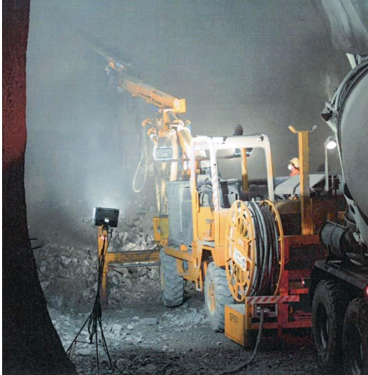
Fotografía 2. 1 Estabilización de taludes y construcción de túneles con shotcrete.
