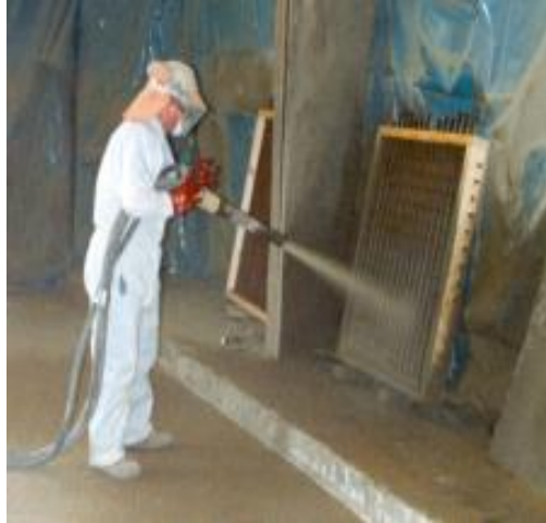
Fotografía 4. 22 Colocación de concreto en forma perpendicular a la superficie
