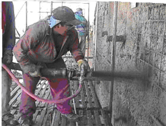
Fotografía 3. 3 Lanzado de concreto alrededor de varillas de refuerzo
