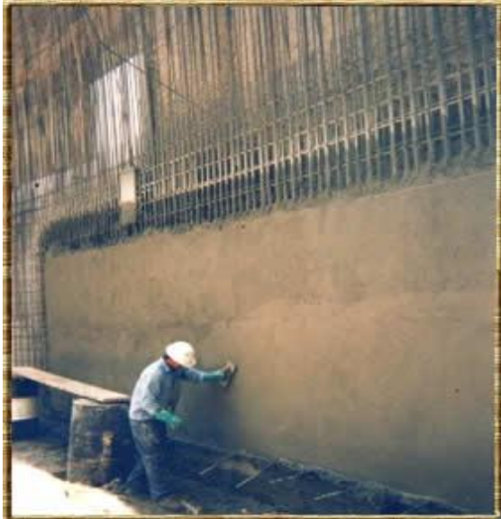
Fotografía 2. 8 En la imagen se observa un shotcrete aplicado en una estructura reforzada
