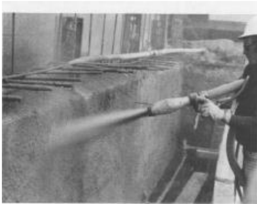
Fotografía 3. 4 Lanzado mezcla seca, sobre una capa de concreto mezcla húmeda
