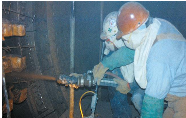
Fotografía 2. 10 Colocación de concreto lanzado refractario.
