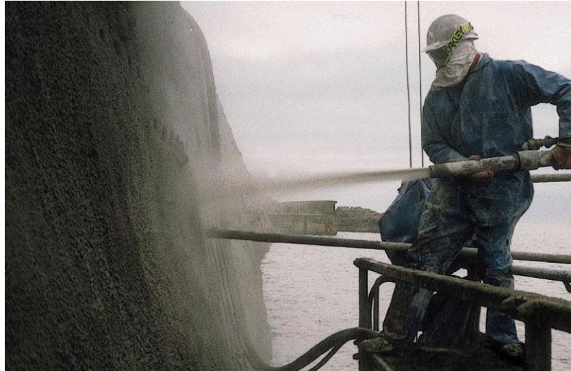
Fotografía 2. 12 Colocación de concreto lanzado en una estructura marina.
