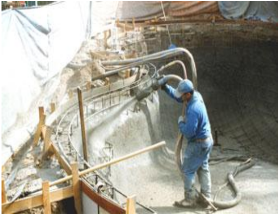
Fotografía 2. 3 Aplicación del concreto lanzado en un ángulo correcto.
