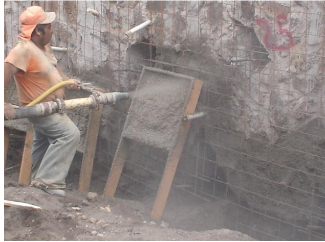
Fotografía 4. 24 Colocación de concreto en el panel
