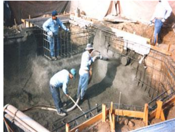
Fotografía 2. 4 Aplicación del concreto lanzado en un ángulo correcto.
