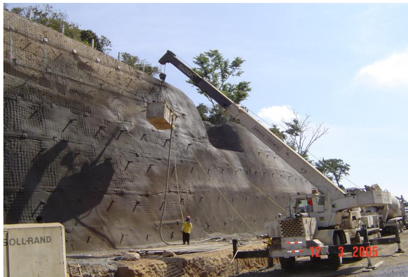
Fotografía 3. 13 Lanzado de concreto en talud
