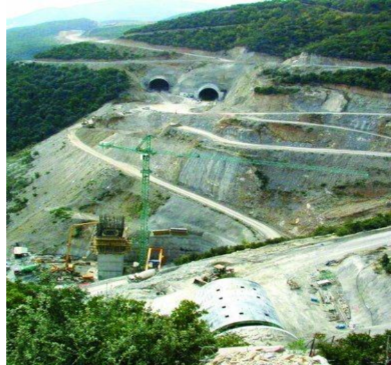
Fotografía 2. 2 Revestimiento de la línea de soporte primario de un túnel con shotcrete.
