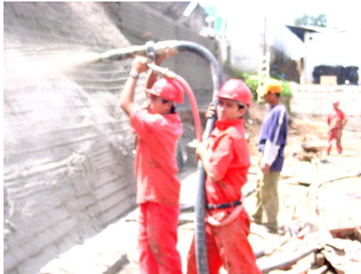
Fotografía 3. 11 Lanzado a distancia y ángulo arbitrario
