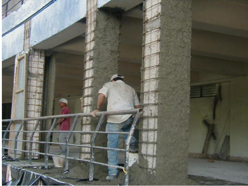
Fotografía 2. 6 Reparación de elementos estructurales (columnas)
