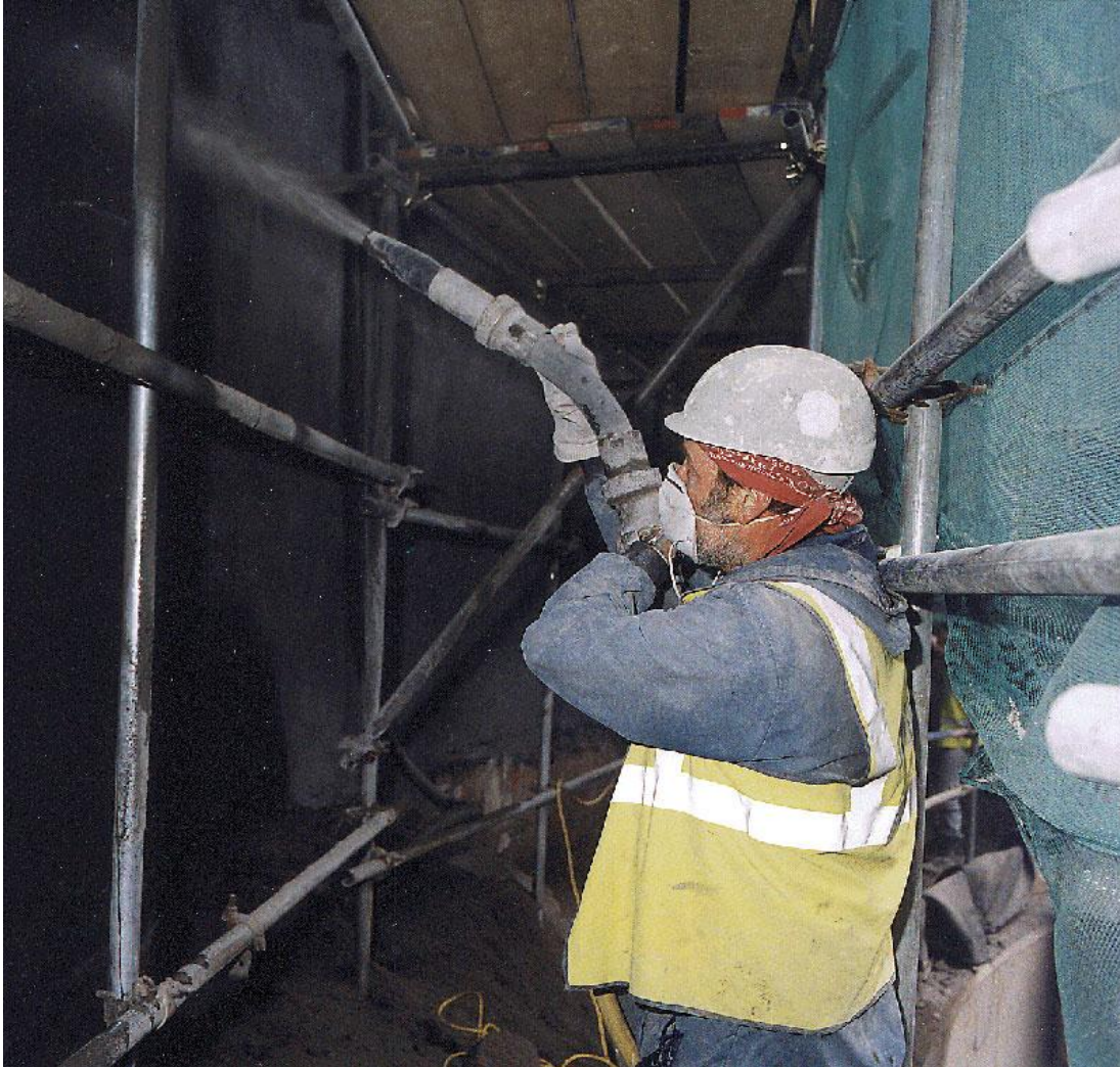
Fotografía 2. 11 Colocación de concreto lanzado en una mina.
