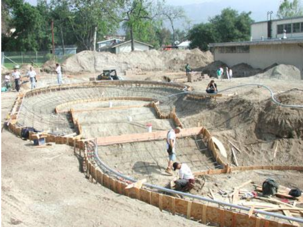
Fotografía 2. 5 Hechura de una piscina con concreto lanzado
