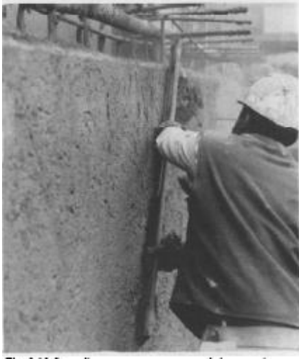
Fotografía 3. 6 Remoción de exceso de material
