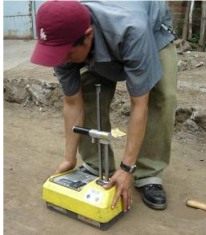
Figura 13.6 Colocación del densímetro nuclear sobre la superficie preparada en el Método de Transmisión Directa para la determinación de la densidad del suelo por métodos nucleares.
