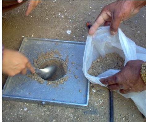
Figura 12.2 Excavación del agujero de ensayo.
