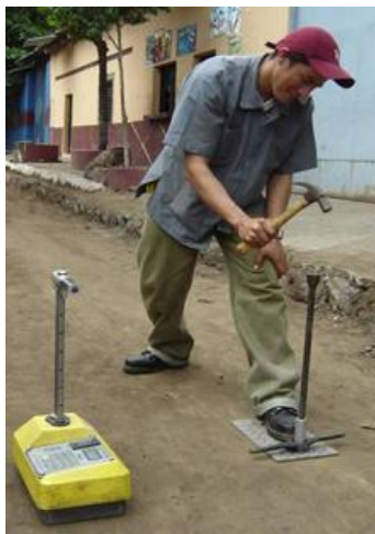
Figura 13.4 Perforación del agujero utilizando la placa de raspado, el extractor de la varilla de perforación y la varilla de perforación por el Método de Transmisión Directa.
