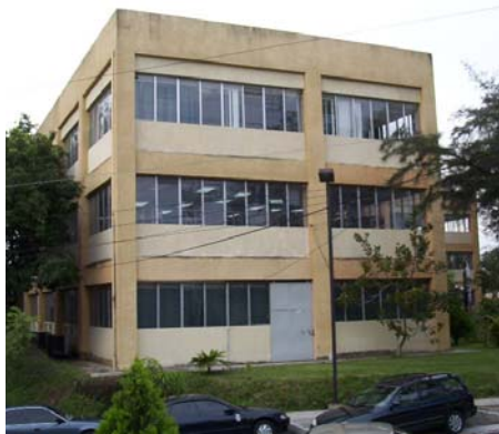
Figura 3. 2 Fachada lateral de la Biblioteca de las Ingenierías y Arquitectura.
