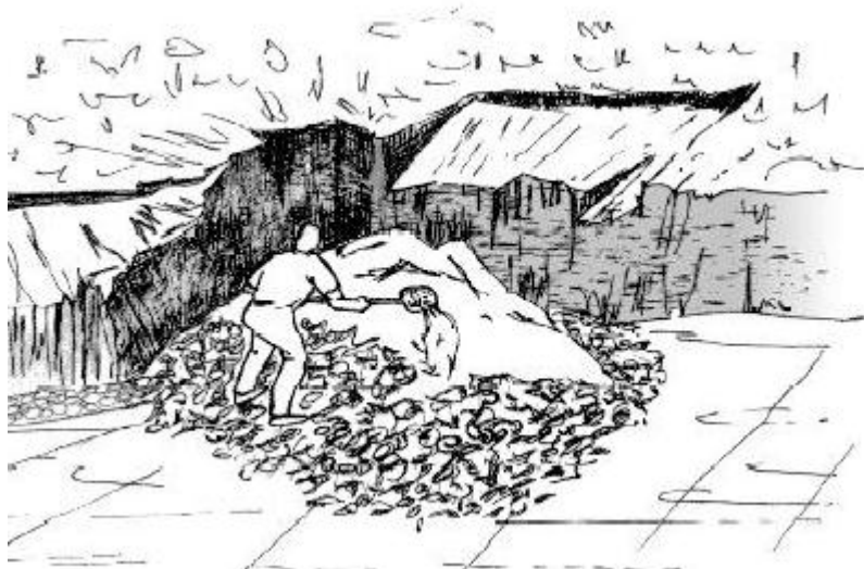
Cubrimiento de los desechos sólidos con tierra.
