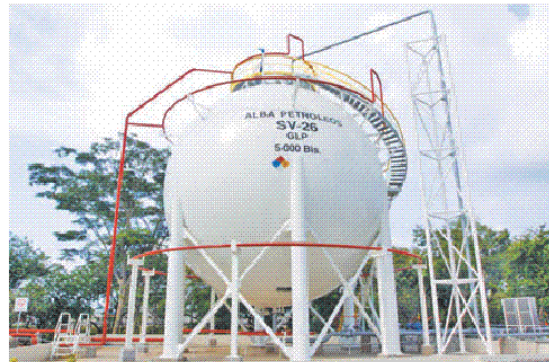
La planta de almacenamiento de combustible de Alba Petróleos está en Acajutla. FOTO EDH / ARCHIVO
