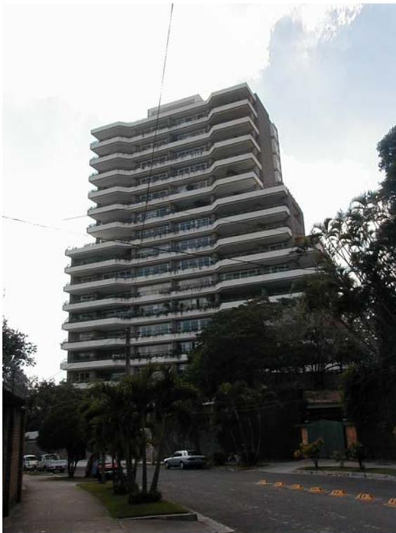
Figura 2.4. Edificio 525 Avenida La Capilla, San Salvador, El Salvador. Terminado de construir en el 2001, este edificio posee 14 niveles mas 2 sótanos y con una altura sobre el nivel del terreno de 49 mts, esta construido con un sistema a base de paredes de cortante (foto: propiedad de Inversiones Bolivar).
