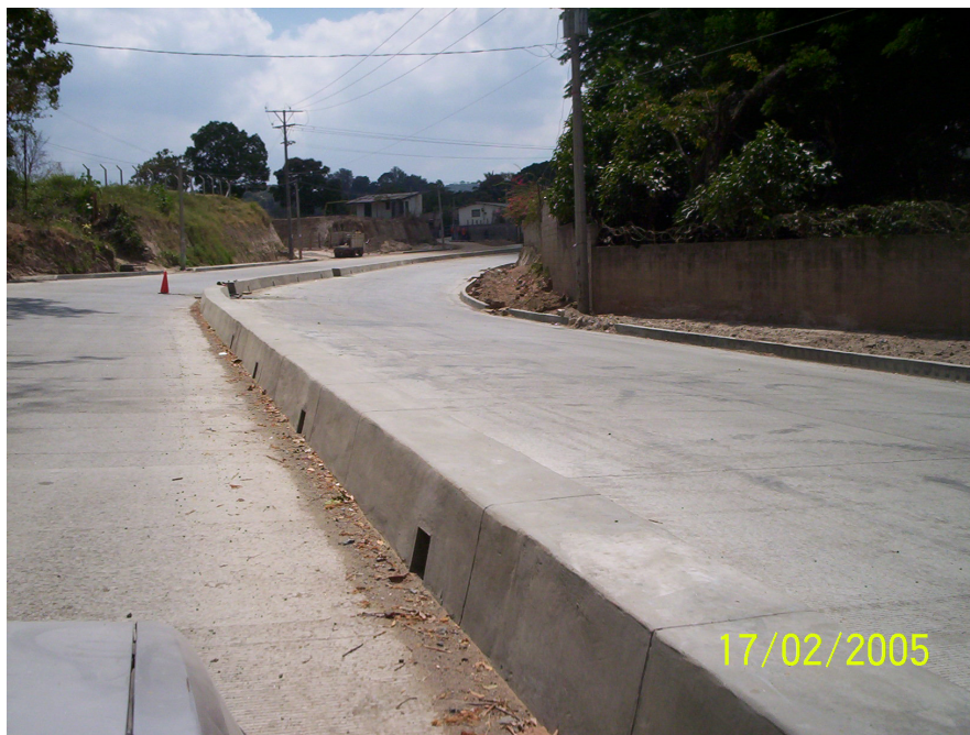
Fotografía N° 6: Curva horizontal de transición.
