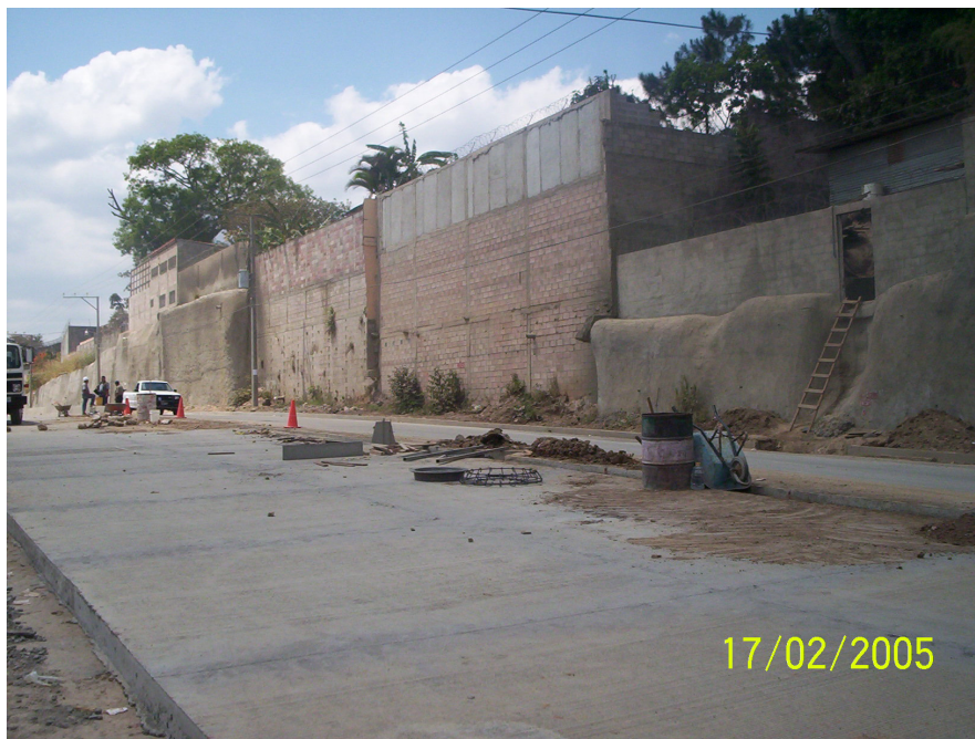
Fotografía N° 8: Tapiales y muros de viviendas aledañas.
