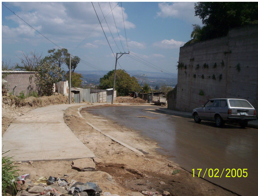
Fotografía 1: Cordón cuneta y acera en construcción.
