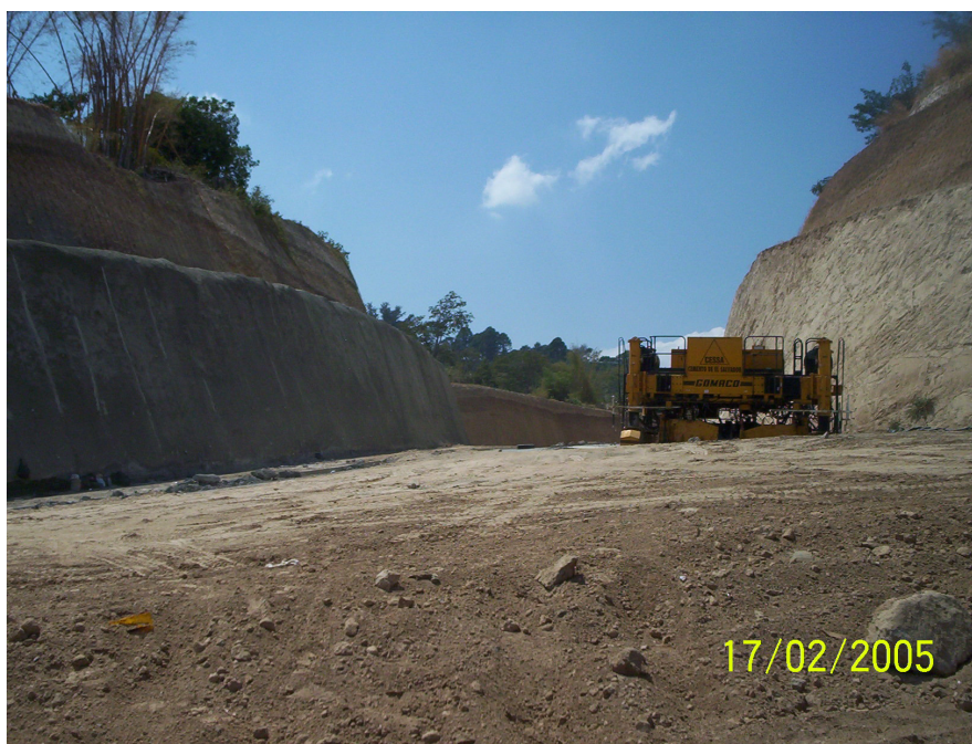
Fotografía Nº 2: Trabajos de terracería concluidos en retorno Nº 2.
