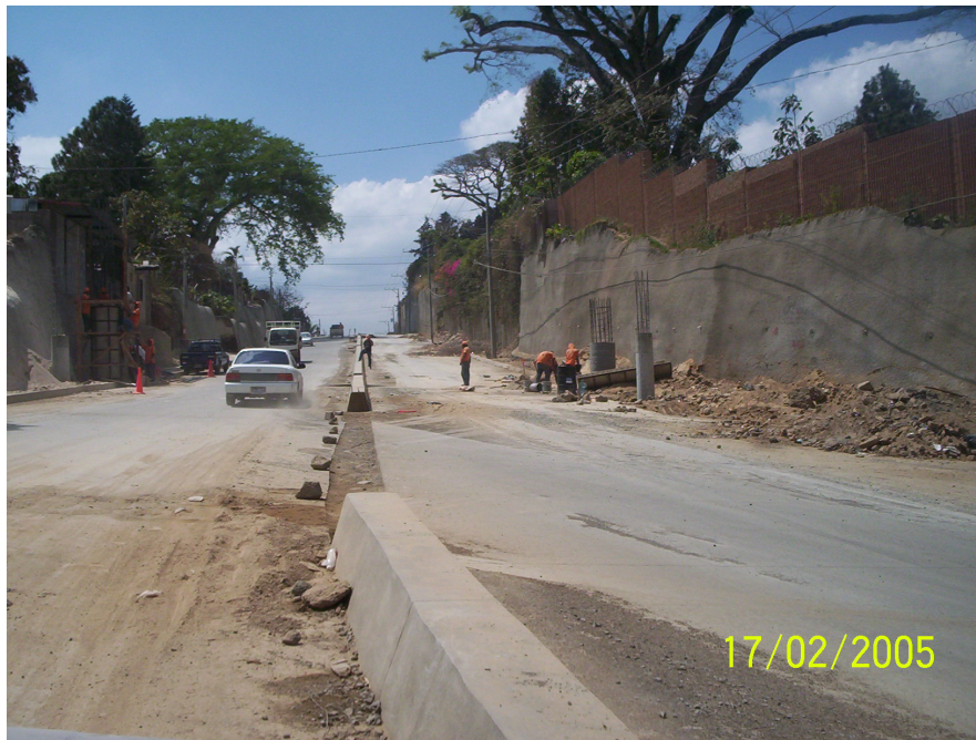
Fotografía N° 7: Separador central en construcción.
