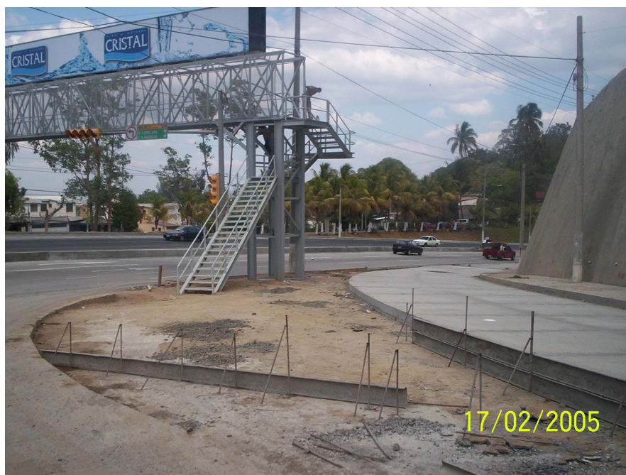
Fotografía N° 10: Pasarela sobre Autopista Comalapa al final del proyecto.
