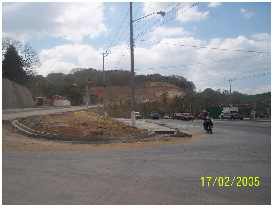
Fotografía N° 12: Panorámica de entronque de la Autopista Comalapa y calle a Huizucar.
