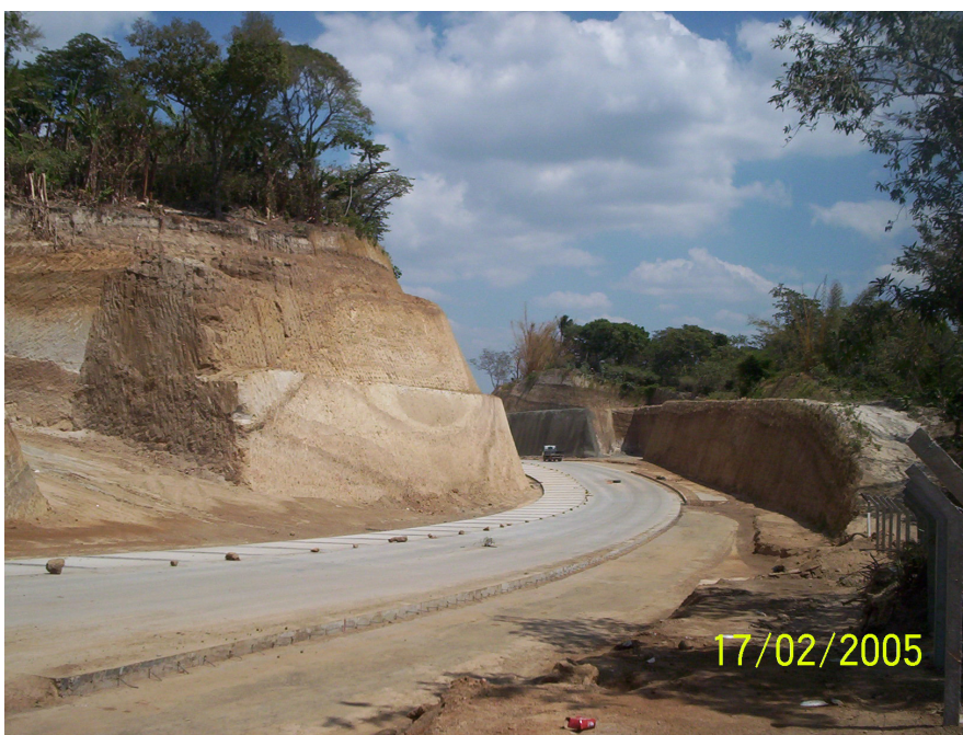
Fotografía N° 4: Vista de talud con dos bermas en retorno N° 2.
