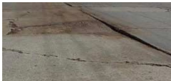
Figura 3.22. Hundimiento. 97
