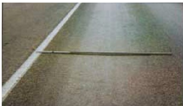
Figura 4.16. Ahuellamiento 123 .
