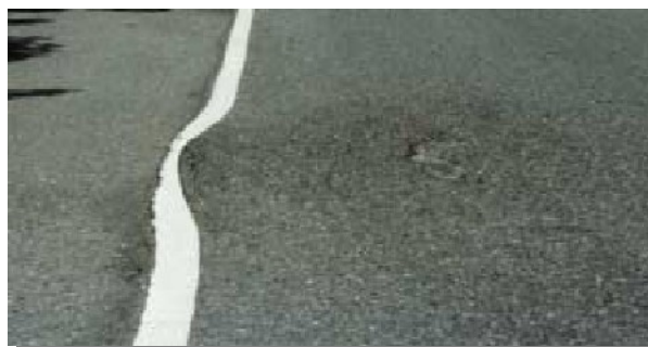
Figura 4.20. Hundimiento 127 .
