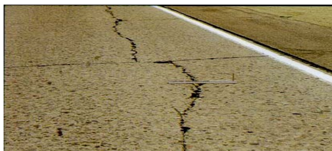
Figura 3.15. Fisura longitudinal. 89
