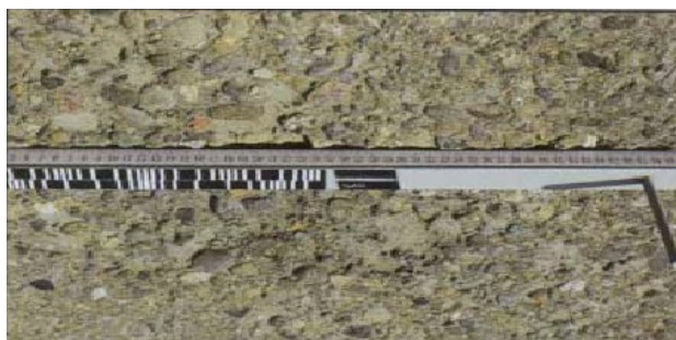
Figura 4.22. Peladura 129 .
