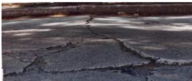
Figura 3.20. Levantamiento de losas. 95
