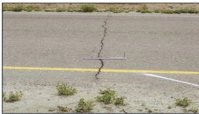
Figura 4.13. Fisura Transversal 120 .
