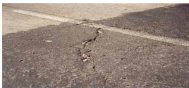
Figura 3.19. Fisura inducida. 94
