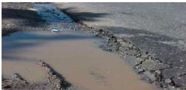
Figura 4.23. Desintegración de Bordes 130 .
