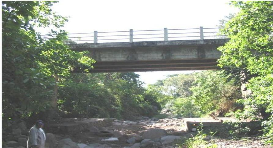
**Fig. 1.7. Puente Apanta, construido a base de vigas de concreto.**
