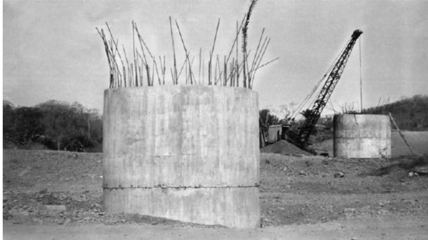
*Fig. 2.31. Hincado de un cilindro por el método del “pozo indio”.
