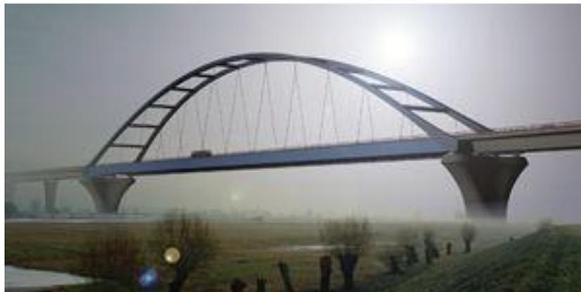
*Fig. 2.9. Puente de Tangermünde sobre el Elba, (Alemania). Longitud del vano: 185 m.*
