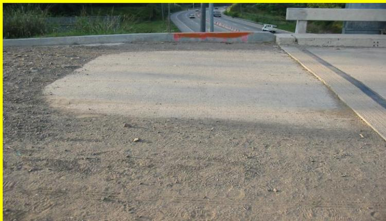
**Fig. 4.11.** En la fotografía se muestra una de las dos losas de aproximación al puente, las cuales se encuentran justo a las espaldas de los estribos. Al fondo, se observa el cordón cuneta que encauza el agua lluvia en la vía superior.
