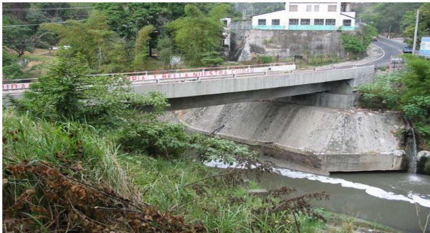
**Fig. 1.4. Puente Agua Caliente sobre el río Acelhuate, elemento principal vigas cajón.**
