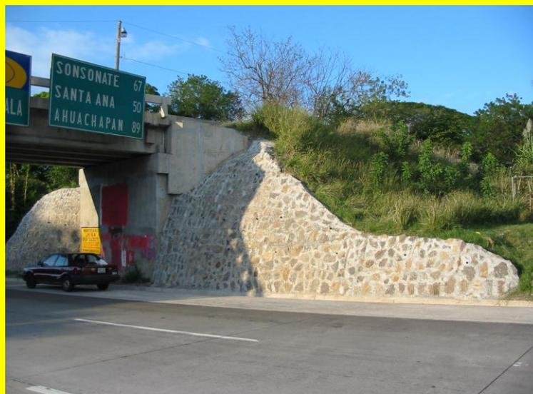
**Fig. 4.2. Protección de los aletones. La fotografía muestra la protección del aletón sur-poniente del puente (que es la misma en todos los aletones), con revestimientos de mampostería de piedra y barreras vivas en el resto del relleno.**
