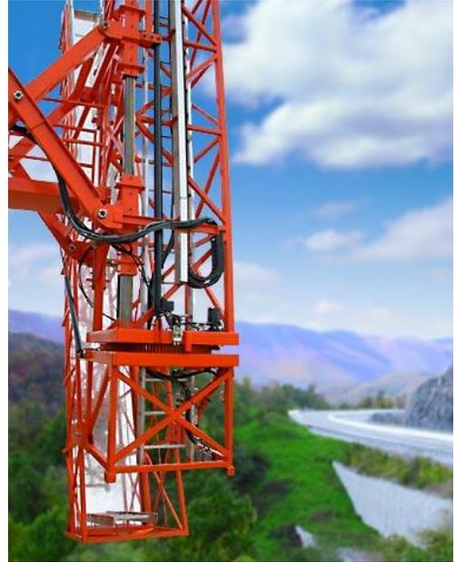
**Fig. 3.7. Erección hidráulica de la plataforma aérea.**
