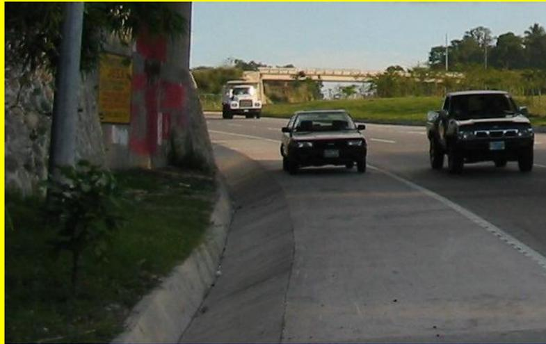
**Fig. 4.4. Canaleta triangular, obra de drenaje inferior.**
