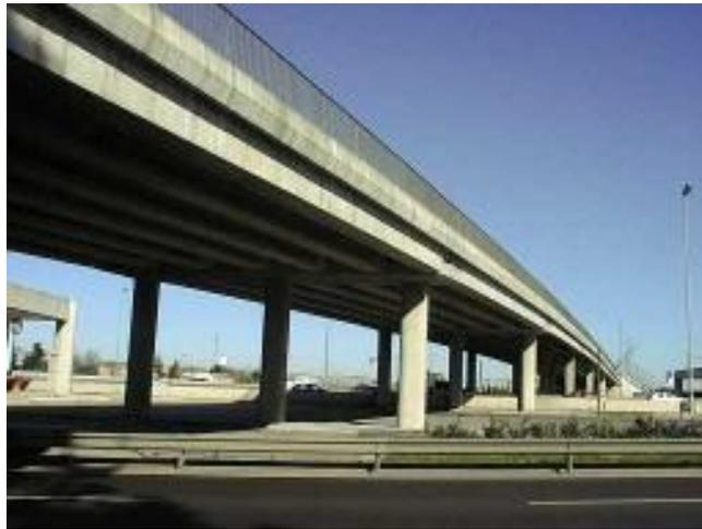
*Fig. 2.10. Puente de Tablero de Vigas.*
