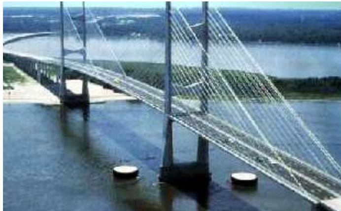
**Fig. 2.21. Puente atirantado con doble plano de atirantamiento.**
