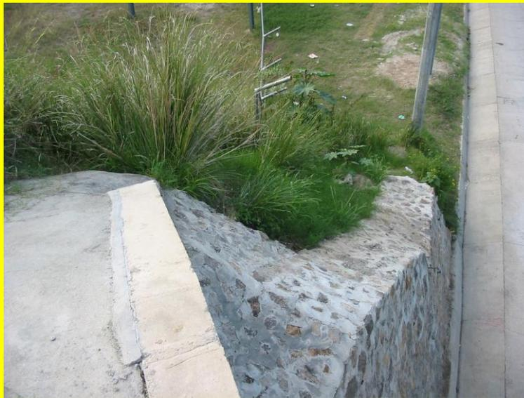
*Fig. 4.3. Relleno de concreto en las espaldas de los aletones.*
