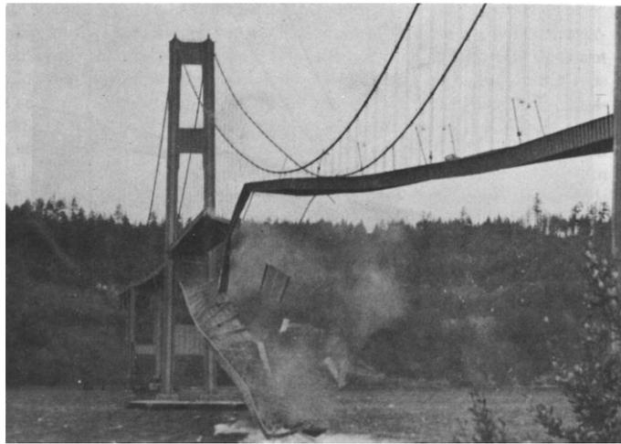
**Fig. 2.37. Colapso del puente Tacoma Narrows.**
