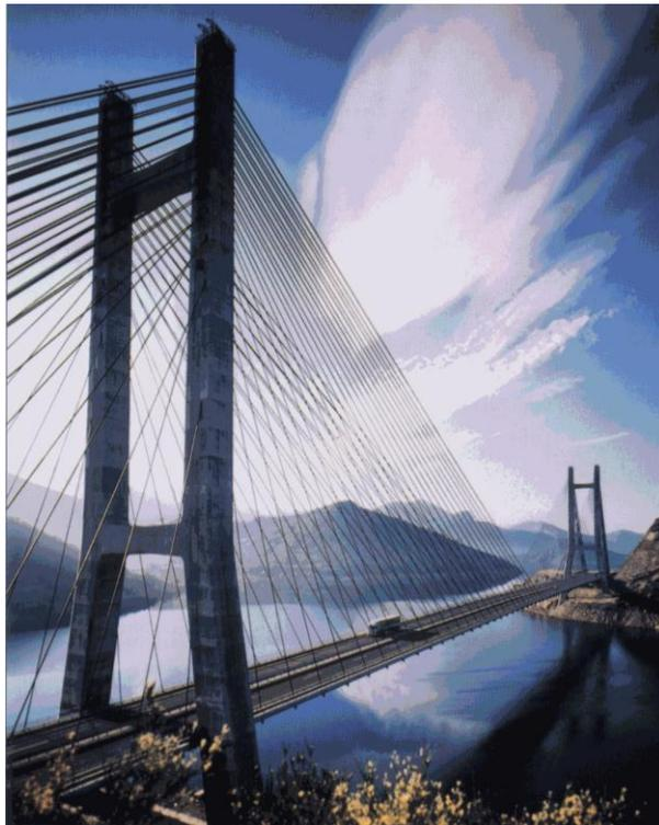
**Fig. 2.20. Puente de Barrios de Luna (España) en 1983. Longitud del vano principal: 440 m.**
