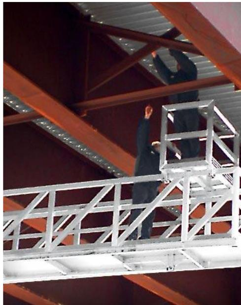
**Fig. 3.10.** En la figura se presenta un andamio adicional que puede ser colocado sobre la plataforma para permitir un mejor acceso a la parte inferior del puente.
