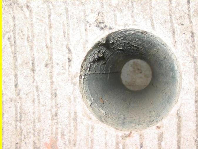
**Fig. 4.7.** En la figura se muestra el estriado transversal de la losa del puente; se aprecia, además, en planta, los pasatubos para el drenaje superficial del puente.
