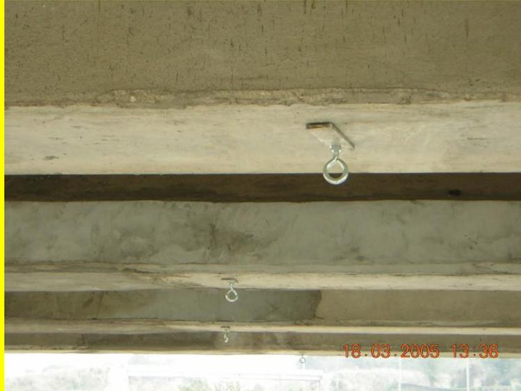
**Fig. 4.34. Pernos de argolla colocados en la parte inferior de las vigas.**
