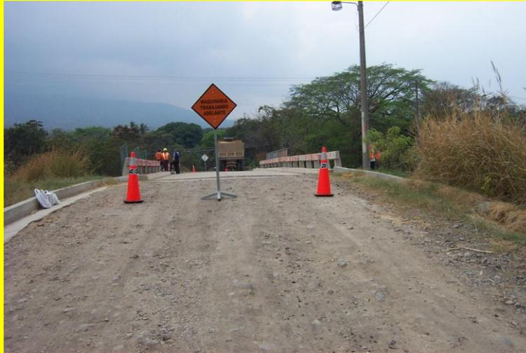
**Fig. 4.36. Señalización de Seguridad Vial colocada en ambos extremos de la vía secundaria sustentada por el puente.**
