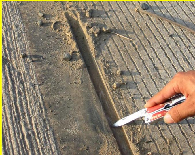
**Fig. 4.8.** En la fotografía se muestra el tipo y estado de una de las juntas de expansión del puente; adicionalmente, se observa el acabado (estriado) de la losa del puente.
