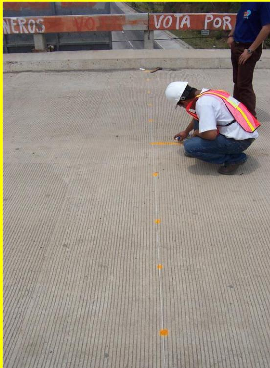
**Fig. 4.35. Trazado de las posiciones de las ruedas de los camiones sobre la losa de pavimento.**
