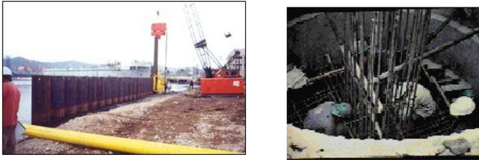
*Fig. 2.30. Tablaestacas y Ataguías.*
