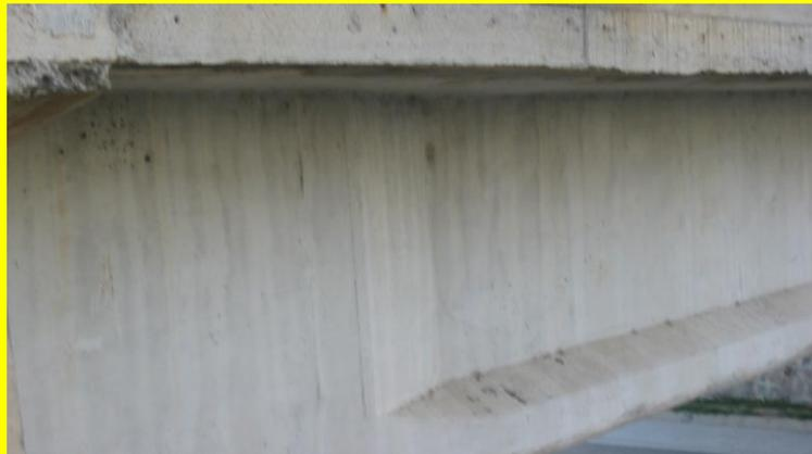
**Fig. 4.5. Ensanchamiento de la parte inferior de las vigas de concreto postensado.**
