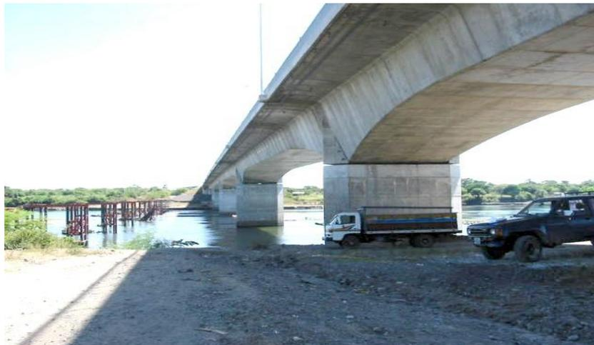
**Fig.1.6. Nuevo Puente de Oro sobre el río Lempa, construido con vigas cajón.**
