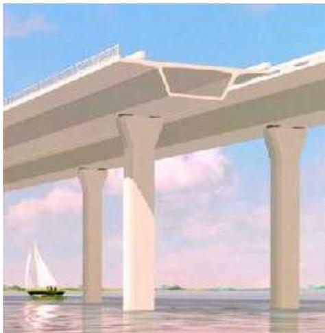
*Fig. 2.15. Ilustración de puente de tablero de viga cajón.*
