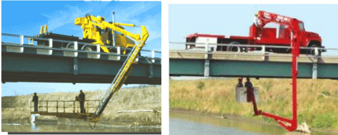
**Fig. 3.2. Utilización de plataformas aéreas en puentes.**
