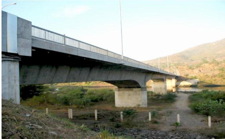
*Fig. 1.1. Nuevo puente Cuscatlán, construido con vigas cajón.*
