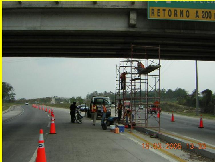
*Fig. 4.33. En la figura se observan los dos cuerpos de andamios levantados bajo el puente.*
