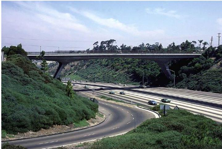
**Fig. 2.16. Pórtico de concreto pretensado de pilares oblicuos. San Diego (USA).
