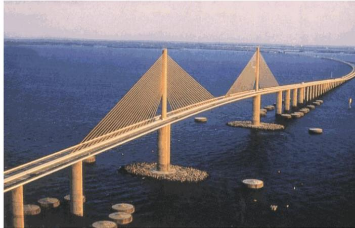
**Fig. 2.22. Puente atirantado con plano único de atirantamiento.**
