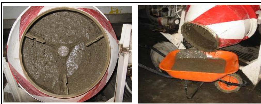
FIGURA 87: Proceso de mezclado en concreteira de sitio, para CAC.
