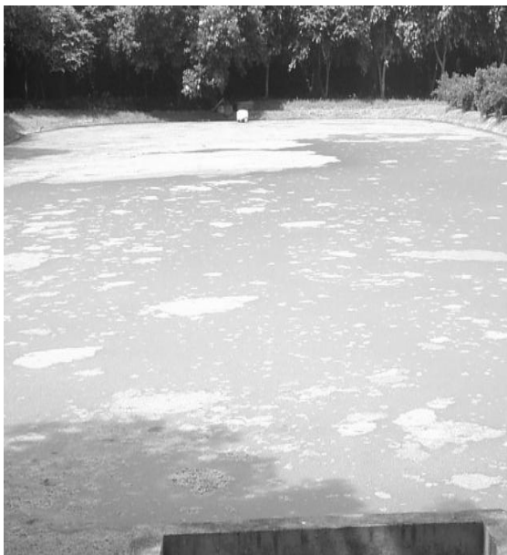
Figura 70. Laguna de estabilización # 1
