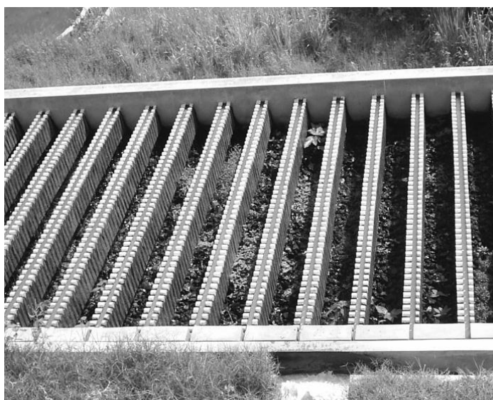
FIGURA 26. Filtro percolador biológico # 3.
