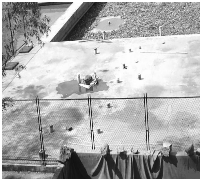
Figura 74. Digestor de contacto de mezclado continuo.
