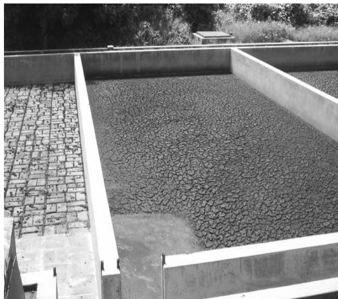
FIGURA 45. Patios de secado de lodos.
