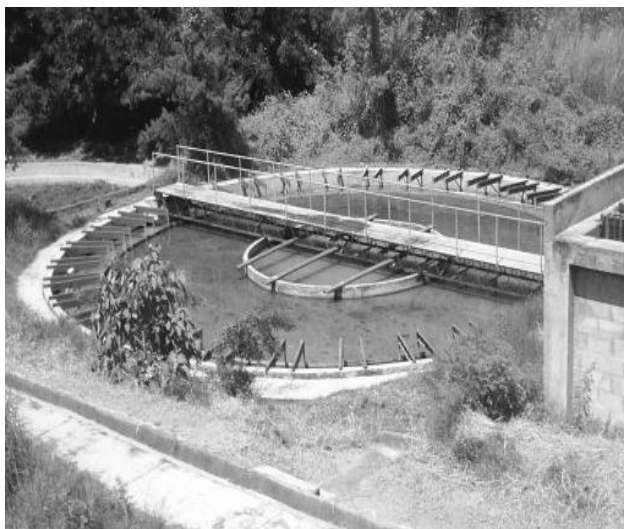
FIGURA 40. Tanque sedimentador secundario tipo Dortmund.
