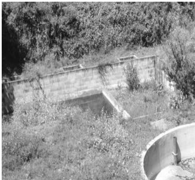
Figura 61. Patios de secado de lodos.
