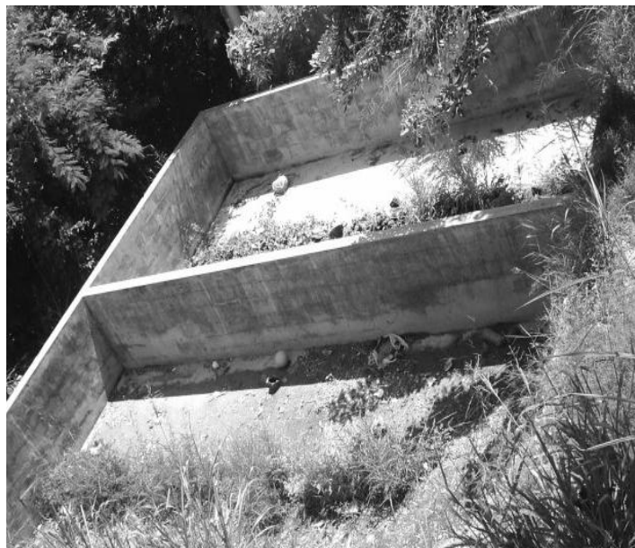
Figura 64. Patios de secado de lodos.
