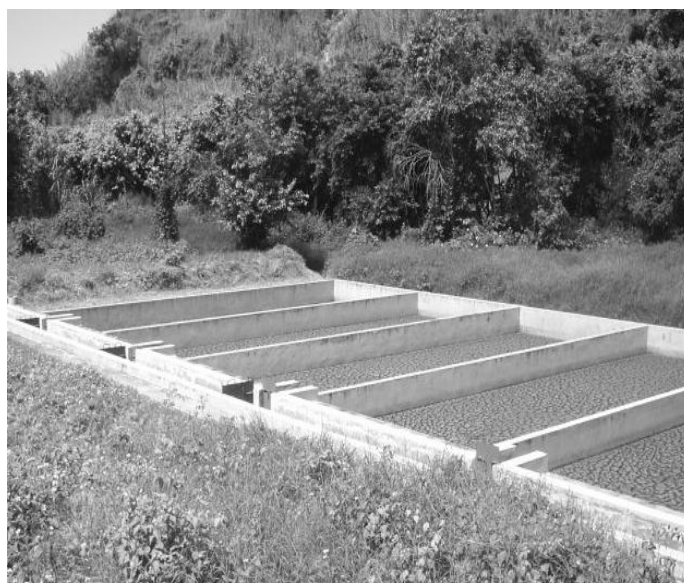
FIGURA 44. Patios de secado de lodos.
