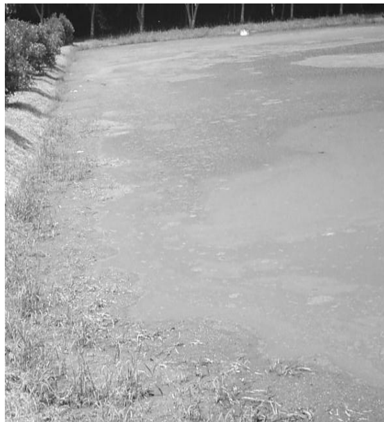
Figura 71. Laguna de estabilización # 2
