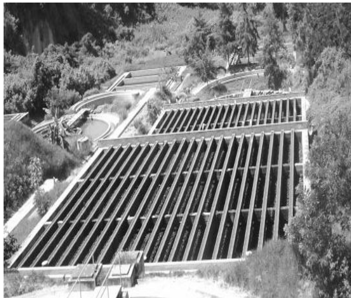
FIGURA 38. Filtros percoladores biológicos.
