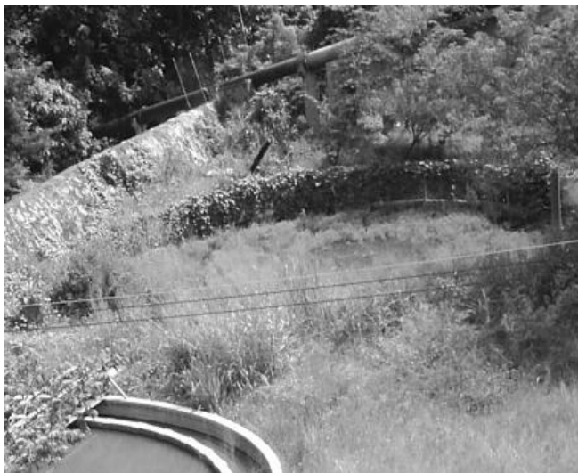
FIGURA 28. Digestor de lodos.
