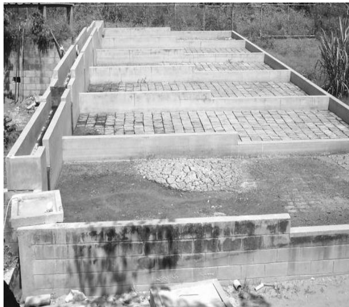
Figura 53. Patios de secado de lodos.
