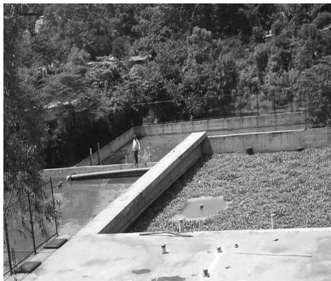
Figura 75. Filtros percoladores anaeróbicos.
