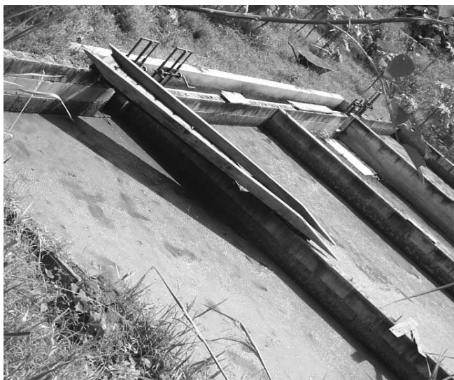
FIGURA 29. Patios de secado de lodos.
