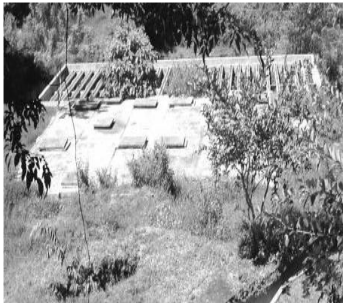
Figura 57. Reactor Anaeróbico de Flujo Ascendente (RAFA).
