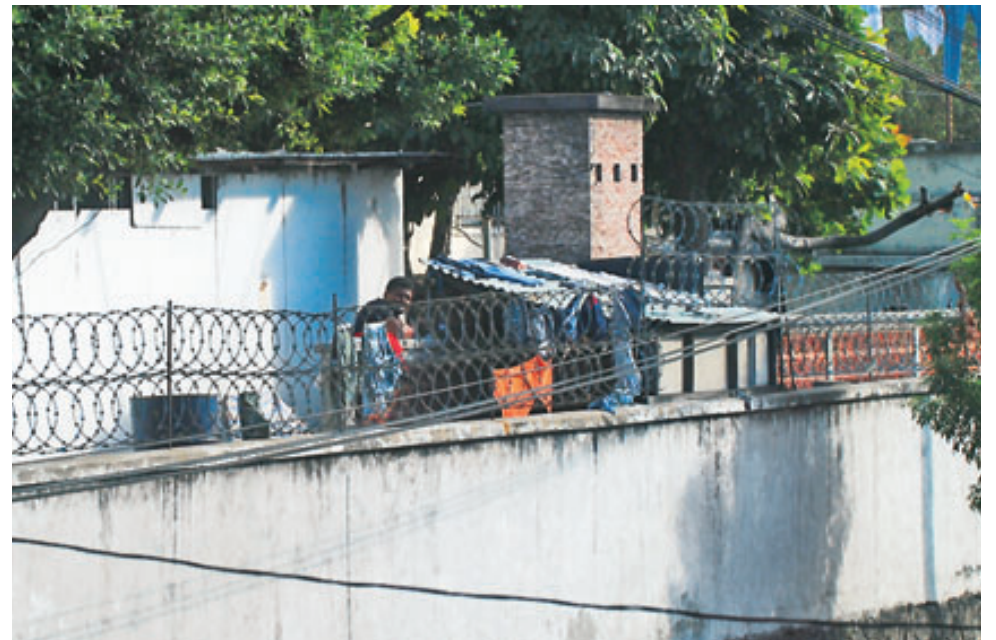
Inmueble que alberga las celdas policiales donde se produjo el incendio. FOTO EDH / MARLON HERNÁNDEZ.
