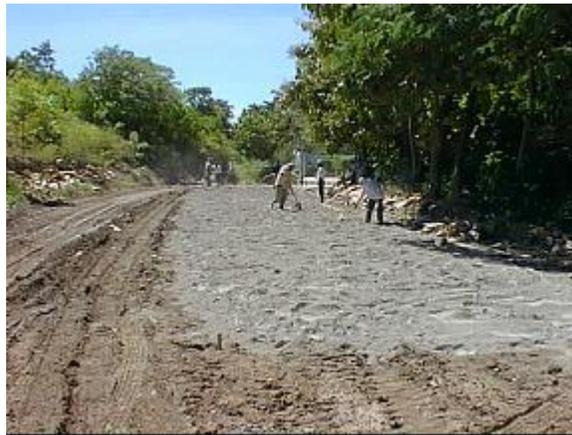
Fig. 3.24: Distribución del cemento sobre la superficie del suelo
