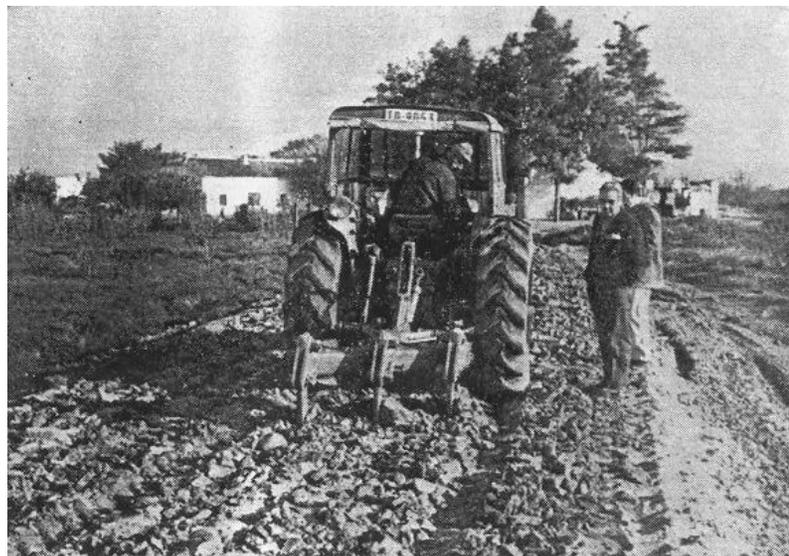
Fig. 2.15: Escarificado del suelo utilizando equipo agrícola.
