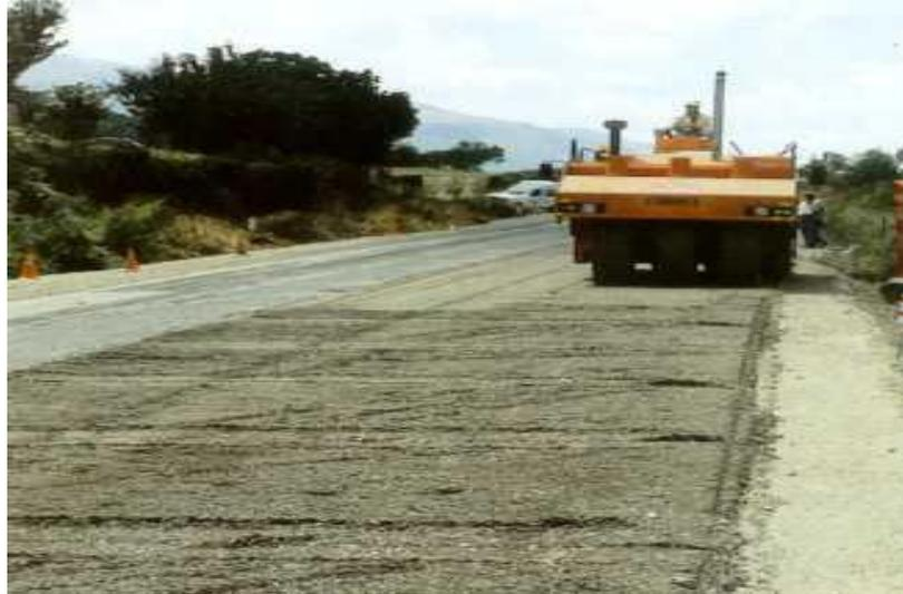
Fig. 2.22: Rodillo de neumático autopropulsado.
