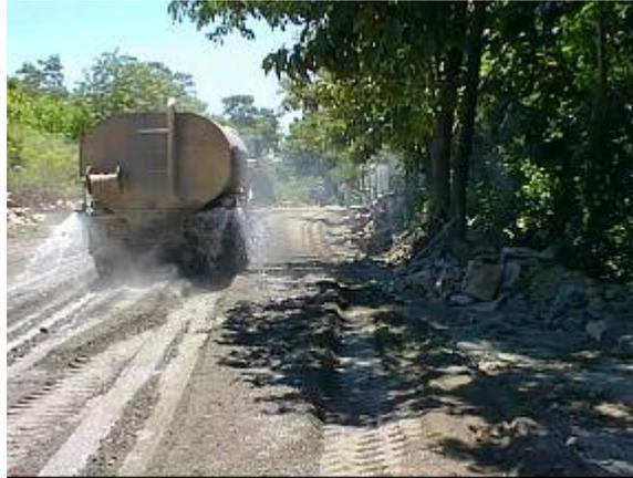
Fig. 3.27: Aplicación de agua después del mezclado del suelo con el cemento
