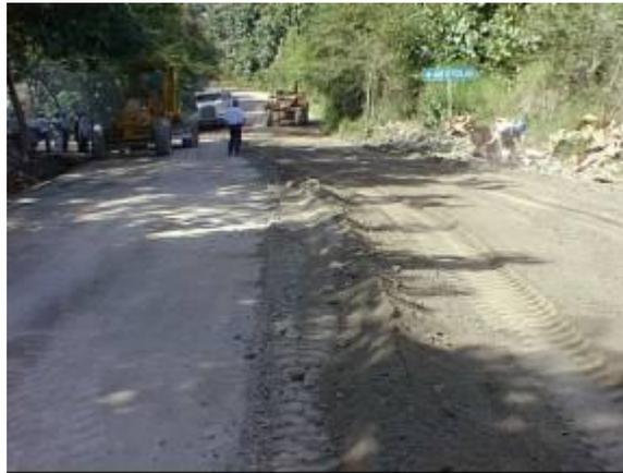
Fig. 3.26: Apariencia del suelo después del mezclado
