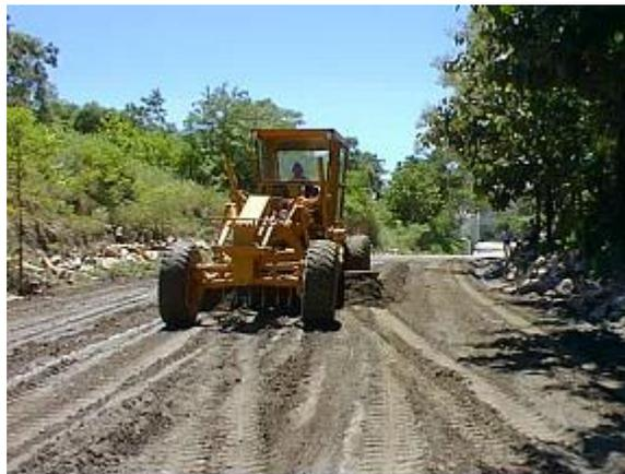
Fig. 3.28: Motoniveladora en labores de homogeneización de la humedad del espesor de la capa del pavimento.
