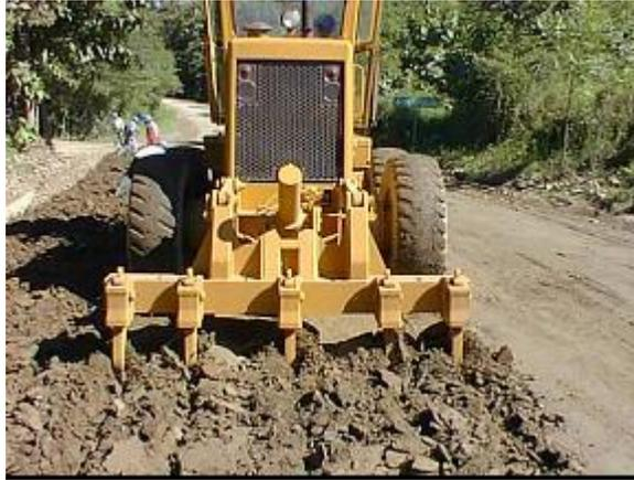
Fig. 3.19: Motoniveladora en actividades de escarificado del suelo
