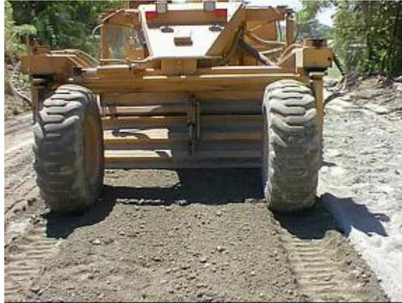
Fig. 3.25: Equipo RR-250 en labores de mezclado del suelo con el cemento
