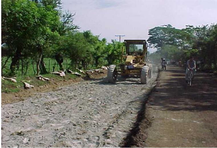
Fig. 2.18: Motoniveladora de hoja intermedia realizando el mezclado.
