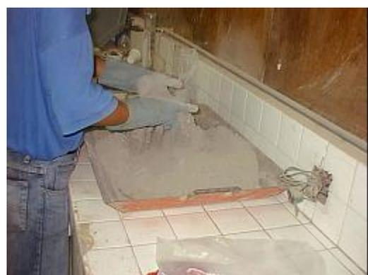
Fig. 3.6: Distribución del cemento en el suelo
