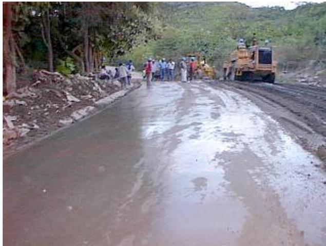
Fig. 3.31: Vista del pavimento después de la compactación y nivelación
