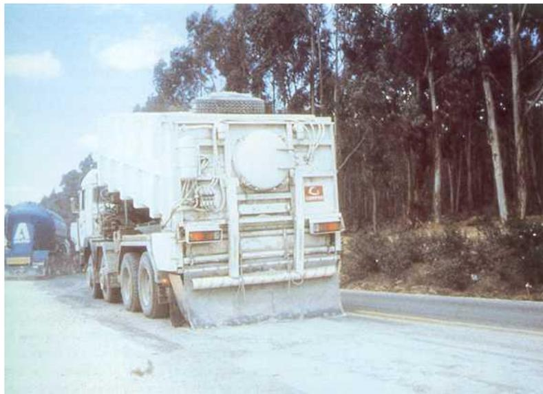
Fig. 2.17: Riego del cemento mediante camiones dosificadores mecanizados
