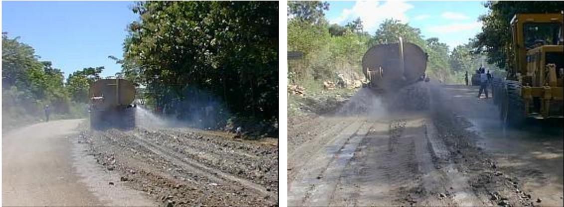
Fig. 3.21: Camión cisterna en labores de adición de agua posterior al escarificado del suelo
