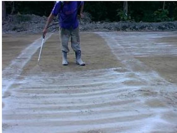
Fig. 3.32: Aplicación de compuesto químico de base acuosa para el curado del pavimento
