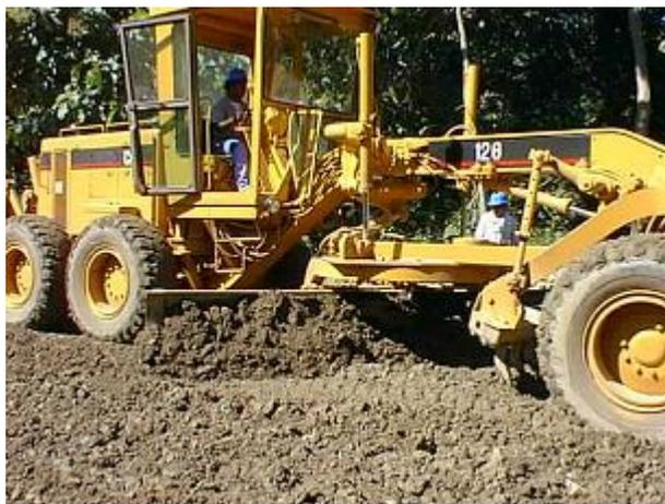
Fig. 3.22: Motoniveladora en labores de conformación de la superficie y pendientes transversales previo a la colocación del cemento.
