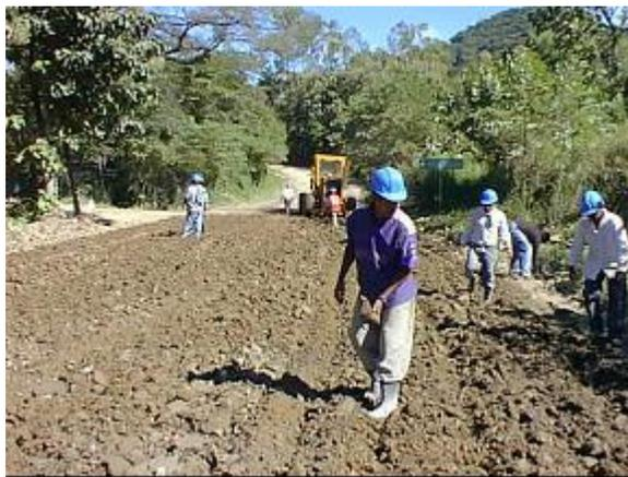
Fig. 3.20: Eliminación de rocas existentes en el suelo
