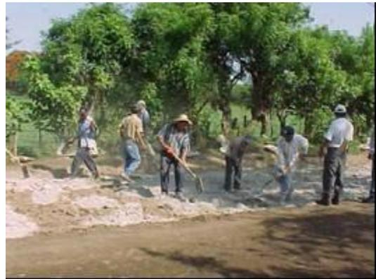
Fig. 2.16: Secuencia de extensión manual del cemento.
