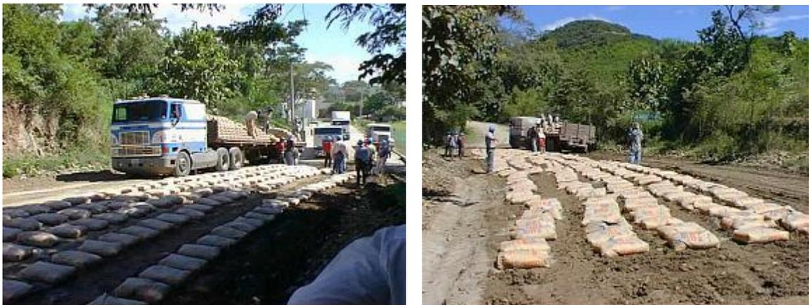
Fig. 3.23: Colocación y distribución de las bolsas de cemento sobre la superficie del suelo.
