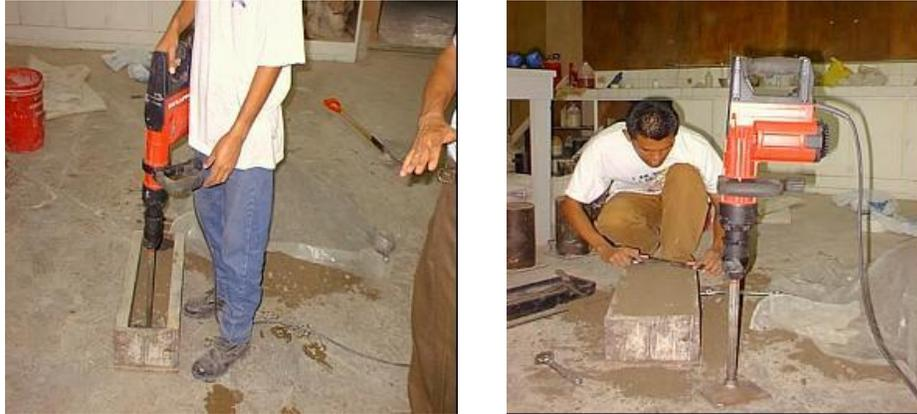
Fig. 3.12: Elaboración de viguetas utilizando el martillo vibro – compactador
