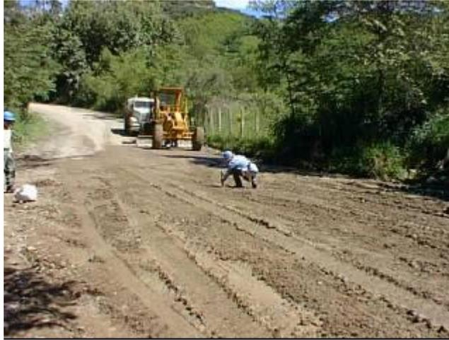
Fig. 3.17: Colocación de estacas guías en el tramo en ejecución
