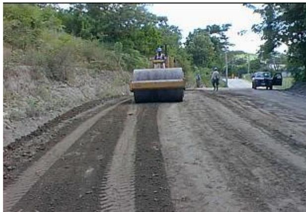
Fig. 3.30: Rodillo liso en labores de compactación final
