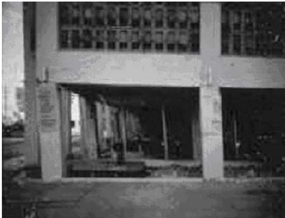
Fig. 1.10 Inestabilidad de pisos Flexibles.
