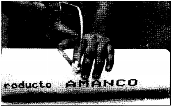
Fig. 3.35 Corte de la tubería con sierra
