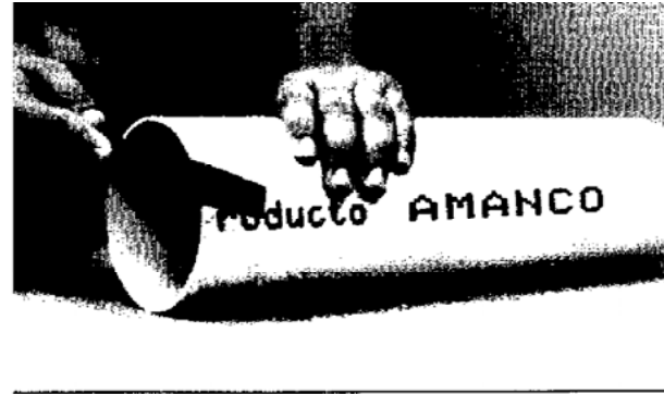
Fig. 3.36 Retiro de desperdicios de tubería con lima o lija.
