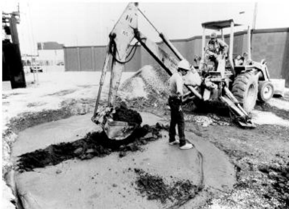
Fig. 4.1 Excavabilidad del RFRC a resistencias mayores de 21 kg/cm<sup>2</sup>
