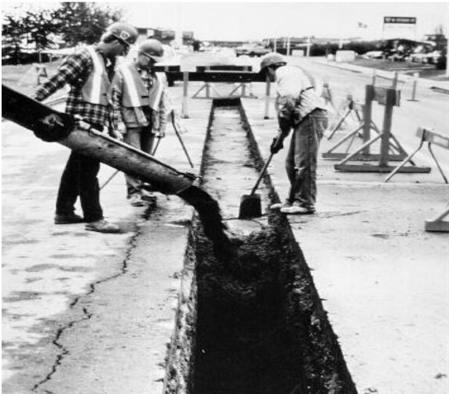
*Fig 4.7 Transporte y colocación del RFRC con camión mezclador*
