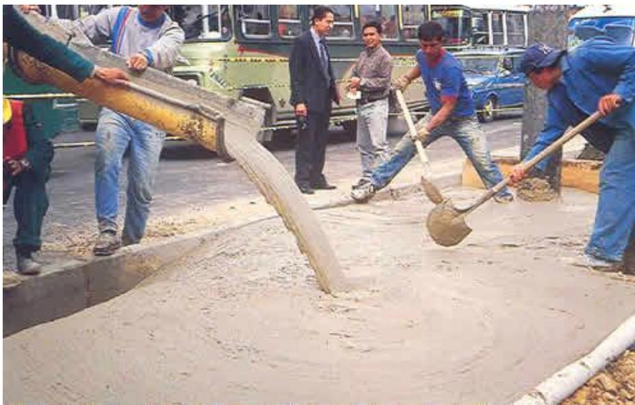
*Fig. 2.2 Colocación de Relleno Semi Fluido*
