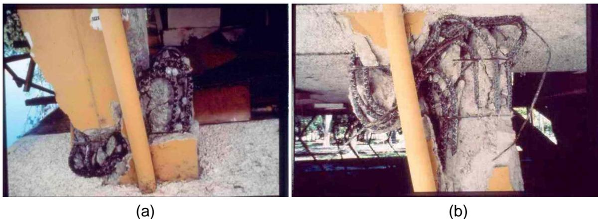
Fig. 2.7 Ejemplo de daño en columna debido a flexión cíclica y cortante pequeño. (a) falla al pie de la columna. (b) falla en la cabeza de la columna. Fotos cortesía de Dr. Ing. E. Portillo
