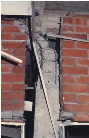
Fig. 2.1 Esquema de efecto de viga fuerte – columna débil, obsérvese el colapso de la columna sin daño visible en la viga.
