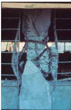
Fig. 2.3 Esquema de efecto de columna corta en una edificación, obsérvese la mampostería que arriestra a la columna, sin estar considerado este efecto en el diseño. Foto cortesía Dr. Ing. E. Portillo
