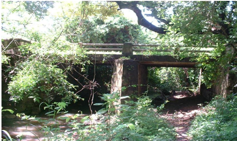
Fotografía N° 5 Vista lateral, Puente sobre quebrada Las Tinajas
