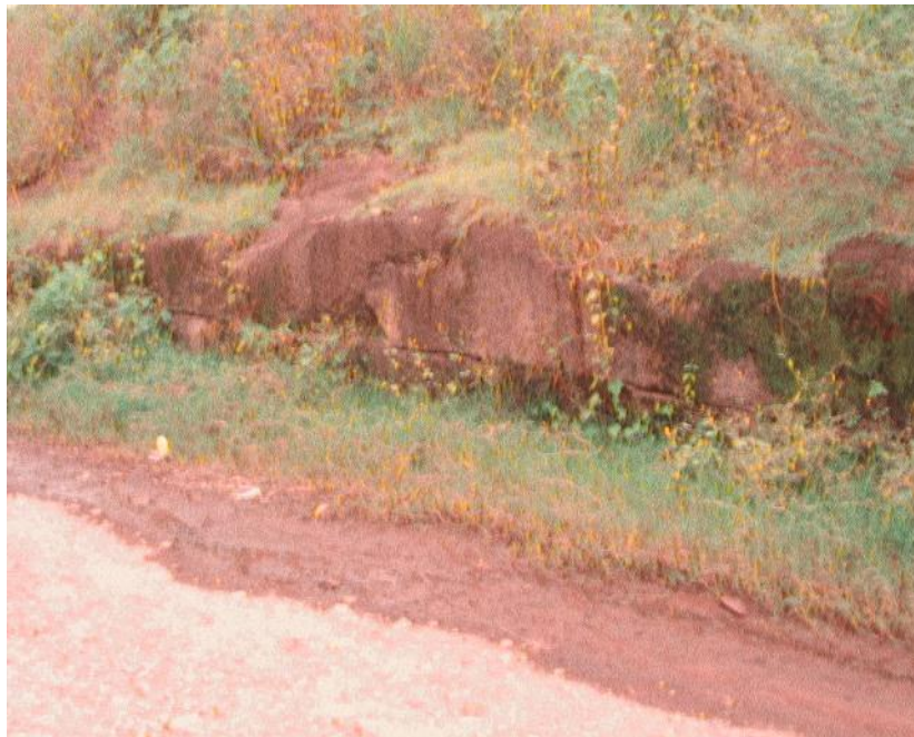
Fotografía N° 4. Afloramiento de agua freática
