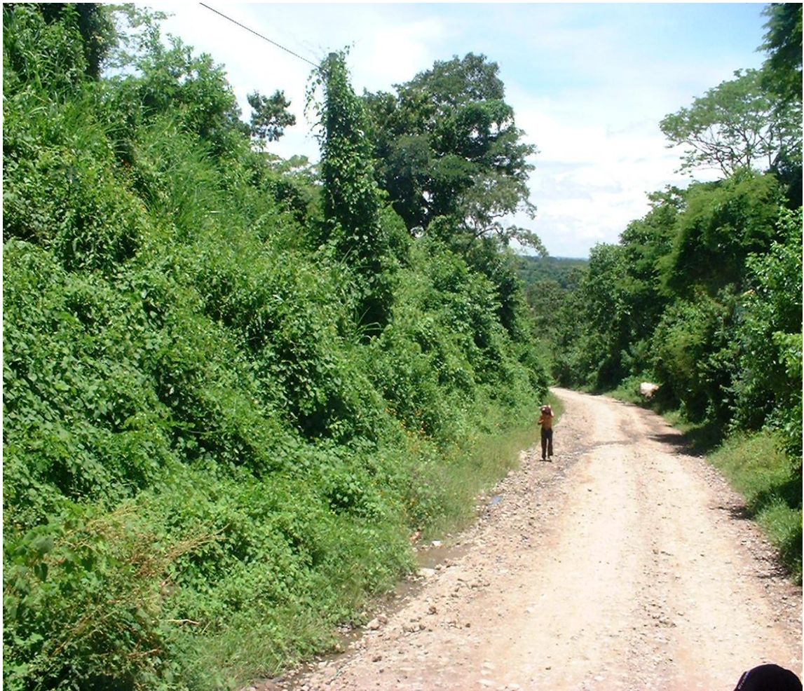
Fotografía N° 7. conformación de taludes en el camino.
