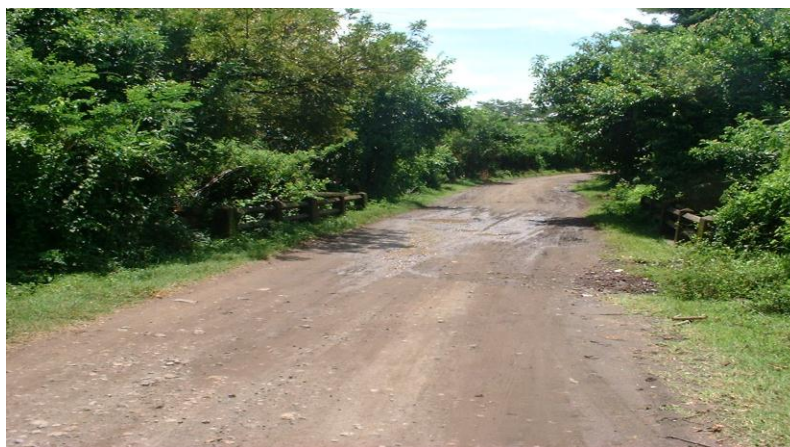
Fotografía N° 6. Puente sobre la quebrada Las Tinajas
