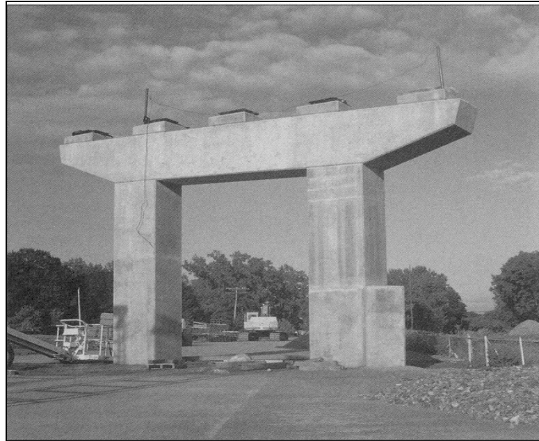
Figura 2.22 Una pila de Cabeza de Martillo de dos columnas.
