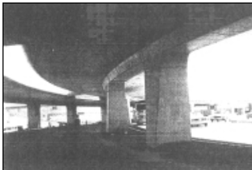
Figura 4.11 Pilas continuas con la superestructura.
