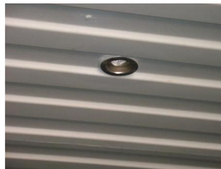
Fotografía #7: Luminaria empotrada en techo del Contenedor Tipo
