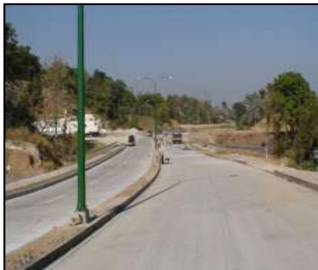
Figura 1.06. Pavimento de Concreto Hidráulico Boulevard Diego de Holguín, Santa Tecla-San Salvador.
