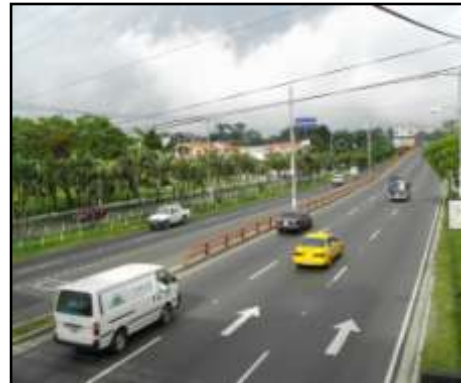
Figura 1.05. Pavimento de Concreto Asfáltico Carretera Panamericana (CA-1)
