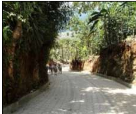
Figura 1.04. Pavimento de Adoquín Cantón San Fernando, Morazán.
