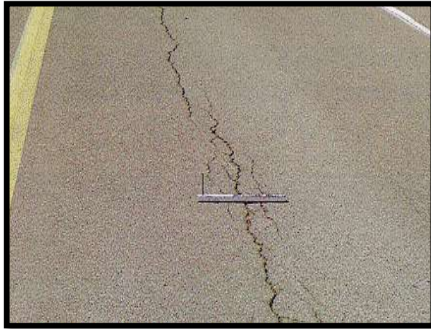
Figura 1.21.- Fisura Longitudinal.
