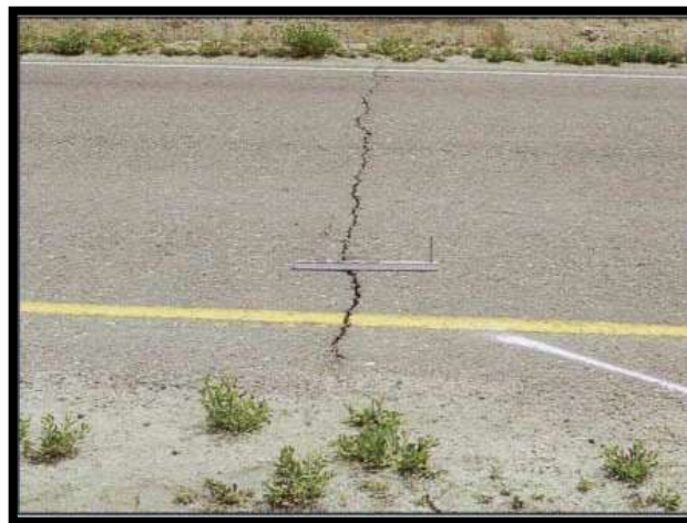
Figura 1.20. Fisura Transversal.
