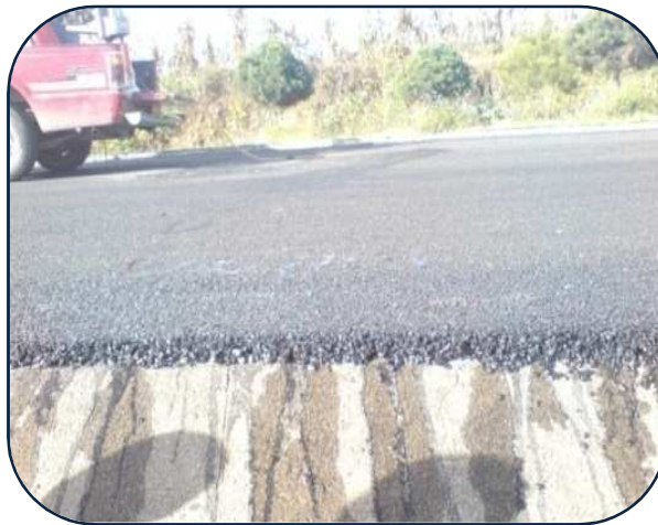
FIGURA 5.1 Verificación de la permeabilidad en una capa terminada
