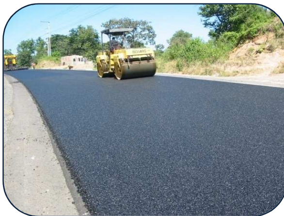
FIGURA 5.2 Compactación de una capa de mezcla drenante, carretera San Martín-San Rafael Cedros.
