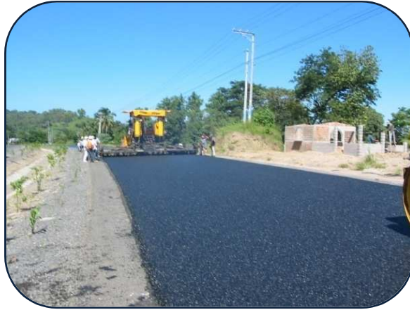
FIGURA 5.7 Extensión de mezcla drenante en tramo San Martin-San Rafael Cedros
