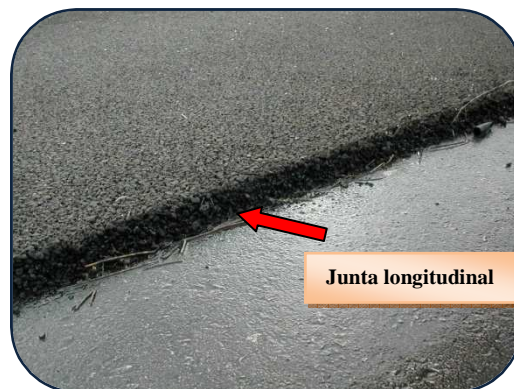
FIGURA 5.6 Junta longitudinal con un buen acabado
