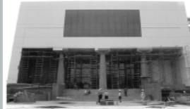
Construcción del Centro Judicial Integrado del Municipio de Soyapango, San Salvador
