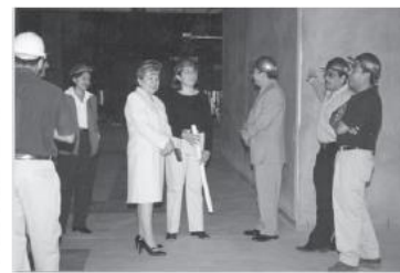
Dra. Victoria Marina Velásquez de Avilés, recorre el edificio en construcción de la Corte Suprema de Justicia, le acompañan técnicos de ingeniería encargados de la obra.
