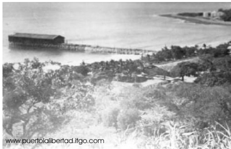
Fotografía N° 5: Vista aérea del muelle antiguo de hierro.
