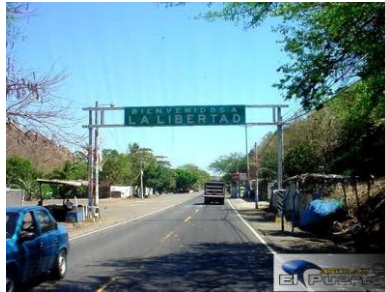
Fotografía N° 1: Carretera CA-4 (Acceso Norte)
