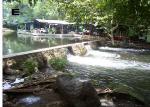
Vista desde el interior del terreno hacia el puente sobre el río Shutecat.
