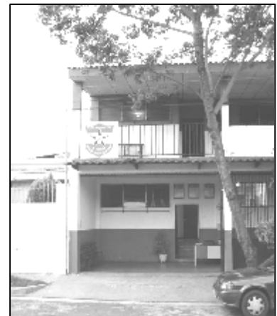
Edificio de la Subdelegación de la PNC en Ayutuxtepeque
