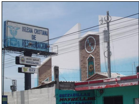
✚ Fachada de la Iglesia Restauración ubicada en final 25 Calle poniente, Santa Ana.
