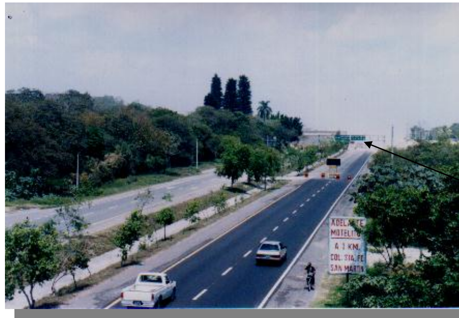
Foto N° 1. Señalización vial al final de la Carretera de Oro
