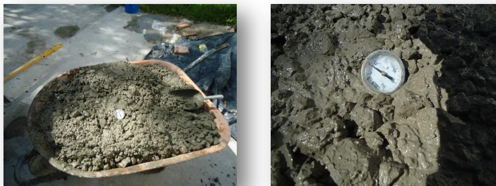
Figura 4.12: Ensayo de temperatura para el concreto fresco Fuente: Propia
