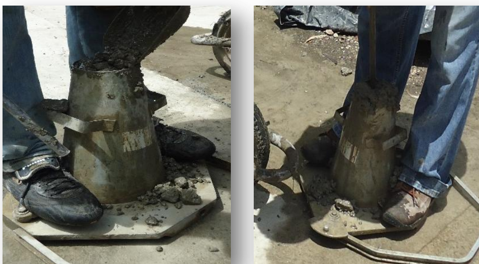
Figura 4.9: Varillado de última capa para revenimiento Fuente propia: Los Autores
