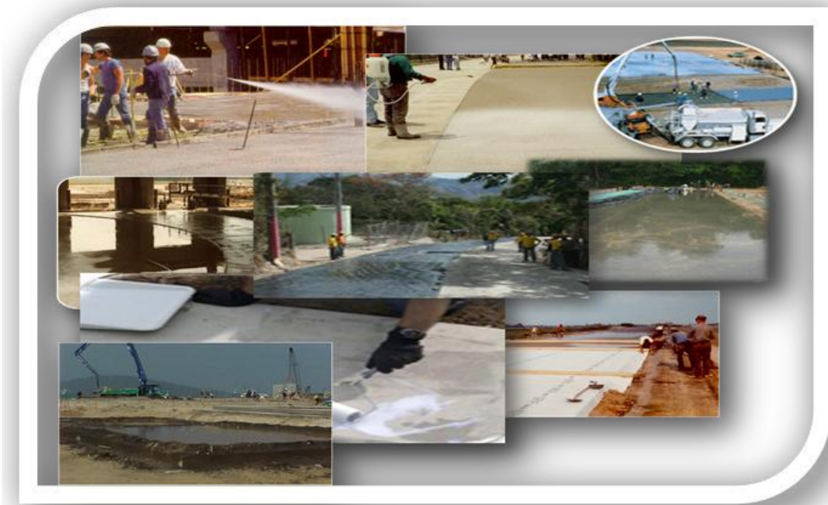
Figura 3.11: Prácticas de protección del concreto Fuente: Material didáctico Tecnología del Concreto FIA UES. Autor Ing. Lesly Mendoza
