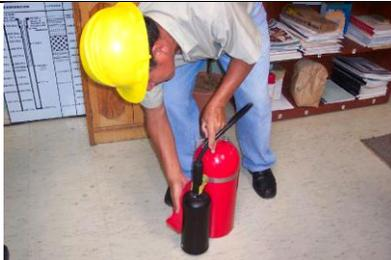
7. Los extintores deberán ser inspeccionados para verificar que no tengan daño físico como corrosión, escape etc. Así mismo se les deberá hacer limpieza como parte de la inspección.
