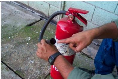
8. Se deberán de inspeccionar las mangueras de los extintores para garantizar que no existe obstrucción y de esta forma evitar el riesgo de que estalle una manguera al momento de accionar un extintor.
