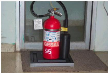
6. A los extintores de tipo CO2 se les debe verificar la carga pesándolos y según la norma NFPA-10 los extintores que ya hallan perdido el 10 % de su peso normal deberán ser sometidos a recarga.
