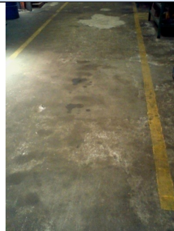
Foto. 16 Riesgos: Físicos y Mecánicos.
