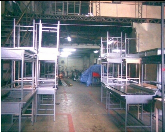
Foto. 27 Riesgos: Eléctrico y Físicos
