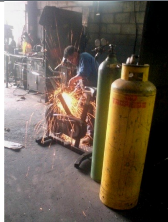
Foto. 8 Riesgos: Eléctricos, Físicos y Mecánicos.
