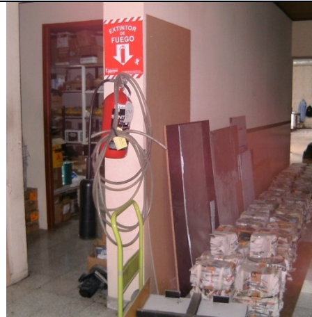
Foto. 14 Riesgos: Eléctricos, Físicos e Incendios.
