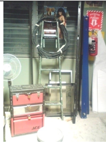
Foto. 12 Riesgos: Eléctricos y Físicos.
