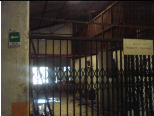
Foto. 31 Zona de Bodega Empresa con una distribución para la ubicación del producto terminado y para el material a emplear, así como la ubicación de la señalización para las vías de evacuación.
