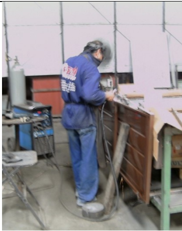
Foto. 17 Riesgos: Eléctricos y Físicos.
