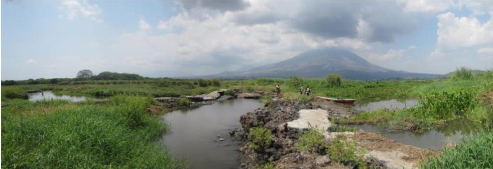
En la fotografía se pueden observar los muros que actualmente “retienen” el agua de la laguna; estos fueron reparados a principios del año 2012, luego de haber sido fuertemente dañados por la DT-12E en octubre del 2011. Los muros están contruidos con gaviones y roca volcánica, por lo que el agua pasa a través de ellos por filtración.
