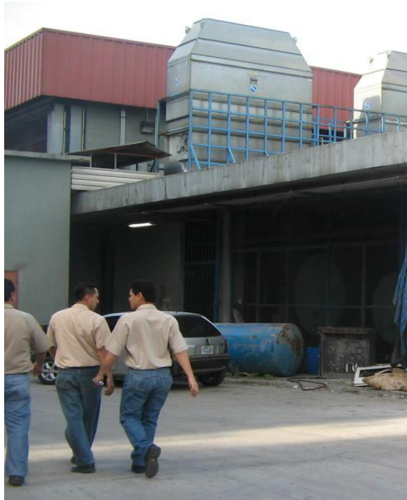
Fig. 3. Entrada a casa de máquinas vista desde el parqueo
