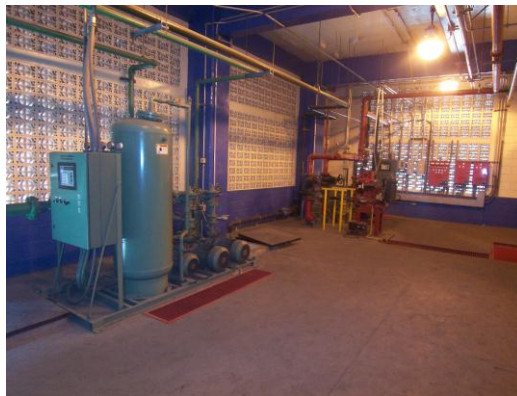
Fig. 6. Sistema de bombeo del hospital general
